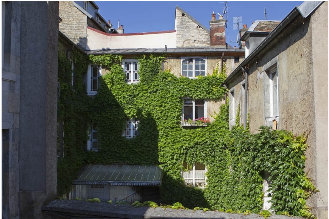
Vue d'ensemble de l'aile contenant l'escalier principal.
