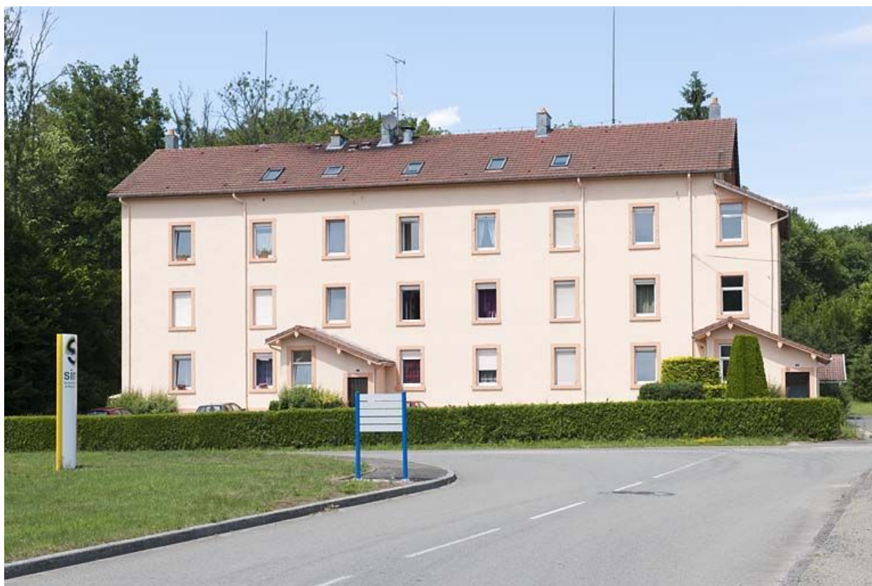
Immeuble dit pension italienne.
