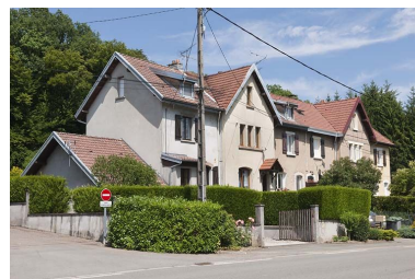
Logement ouvrier Q. Phot. Jérôme Mongreville IVR43_20112501212NUC4A
