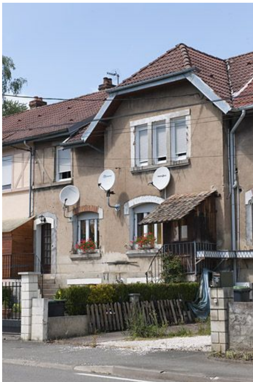
Logement ouvrier P. Détail de la façade.
