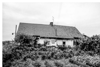
Ferme cadastrée 1949 B1 323 et 325 : façade antérieure. Phot. Bernard Pontefract IVR43_19753900465Z
