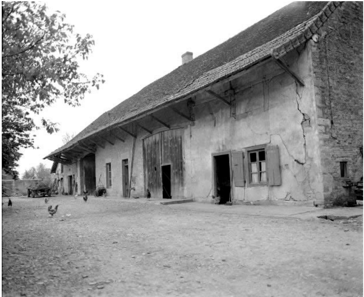
Ferme située rue de Beaurepaire.
