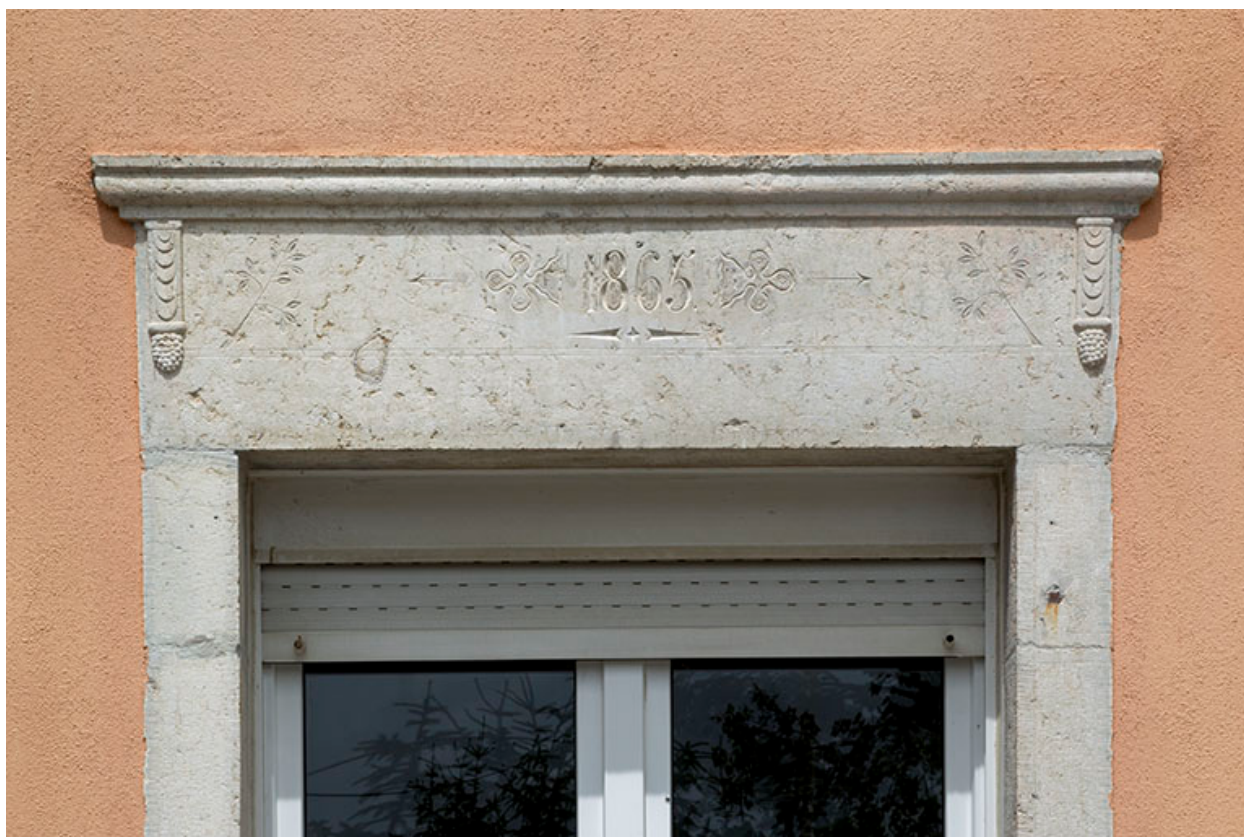
Façade postérieure : ancienne porte avec linteau daté.
