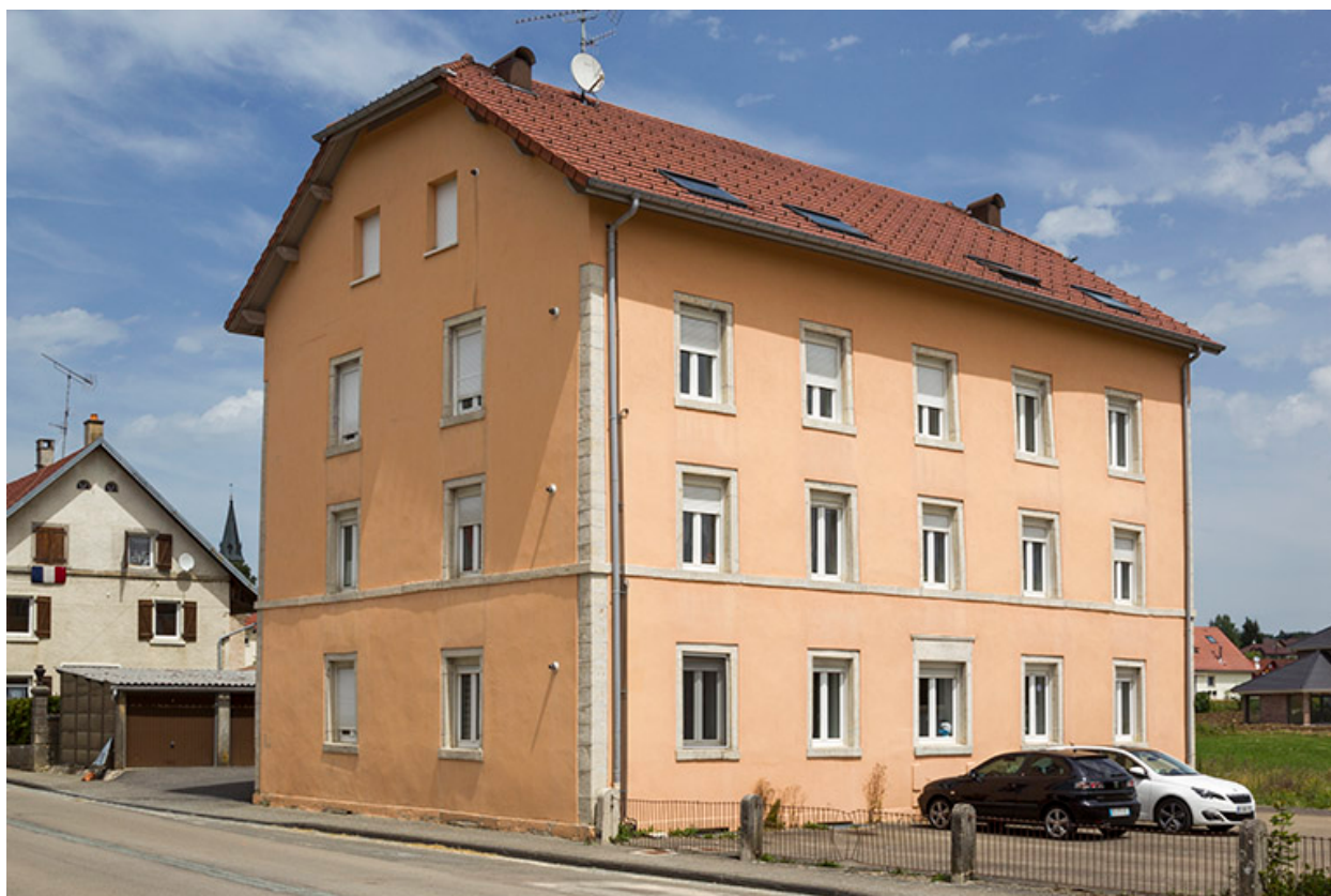
Façades postérieure et latérale droite.
