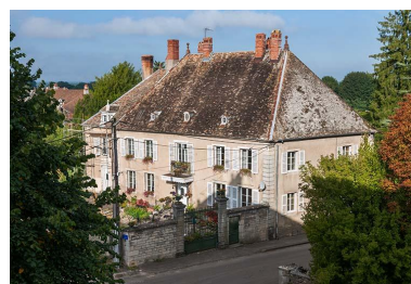
Vue générale sud-est Phot. Jérôme Mongreville IVR43_20137000311NUCA
