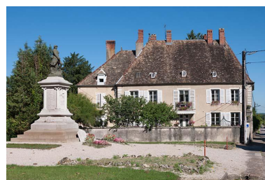
Vue sud Phot. Jérôme Mongreville IVR43_20137000290NUCA
