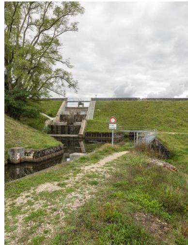
Vue du déversoir. Phot. Pierre-Marie Barbe-Richaud IVR26_20177100321NUC2A
