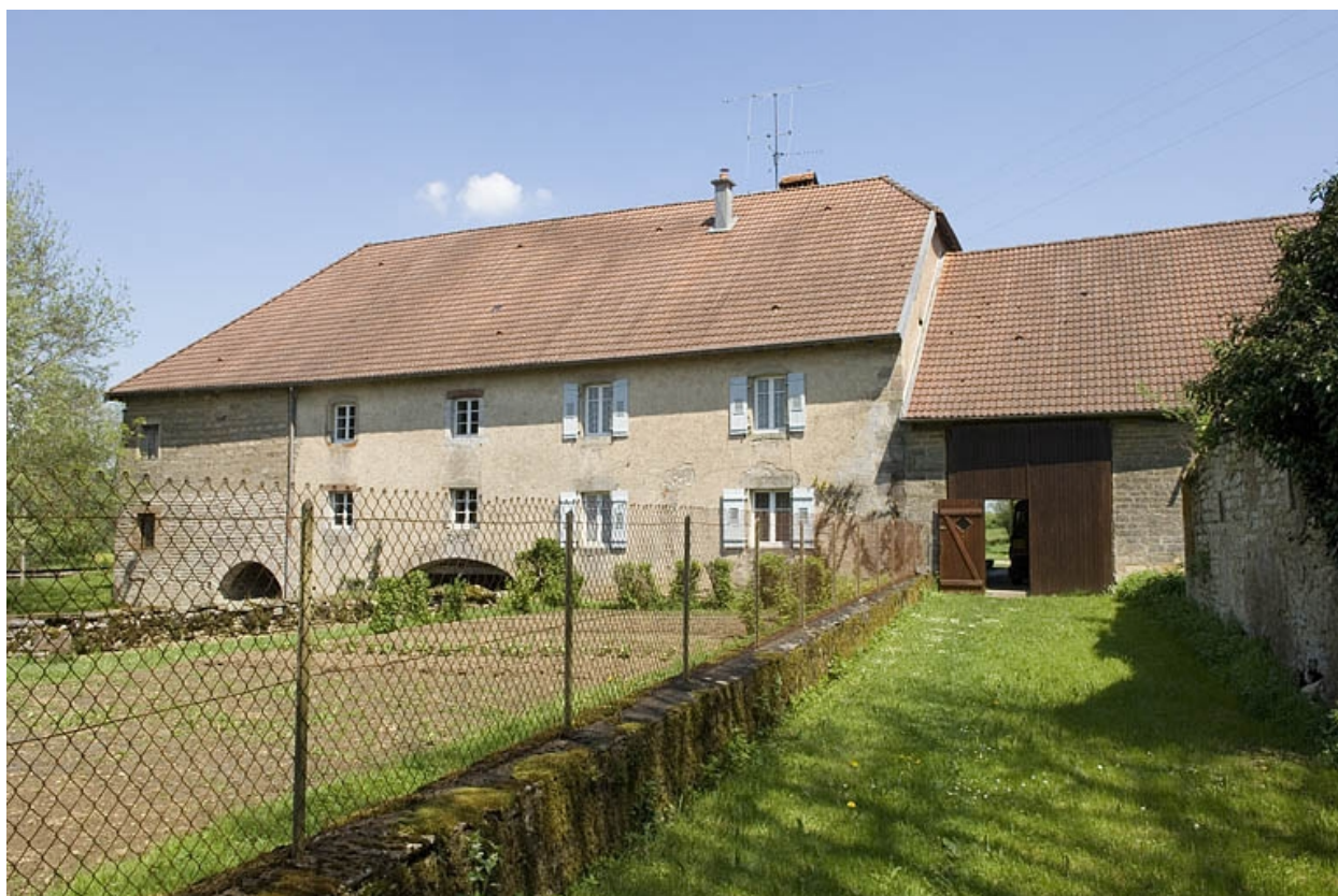
Façade postérieure du moulin.
