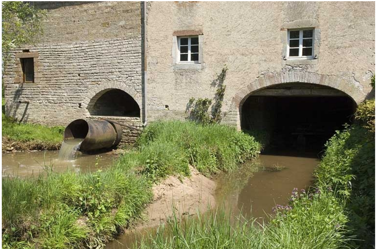
Canal de fuite.
