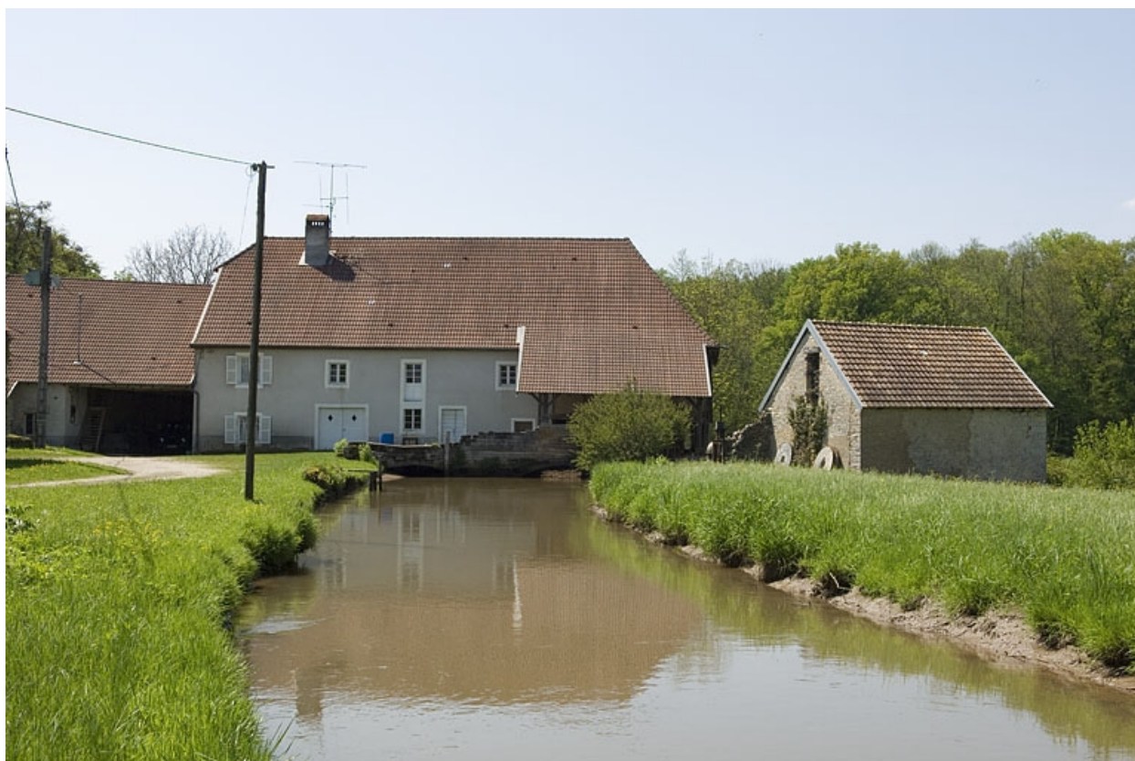
Vue d'ensemble depuis l'amont du bief.
