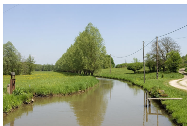
Bief d'amenée. Phot. Jérôme Mongreville IVR43_20067000265NUCA
