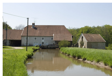
Vue d'ensemble depuis l'amont du bief. Phot. Jérôme Mongreville IVR43_20067000263NUCA
