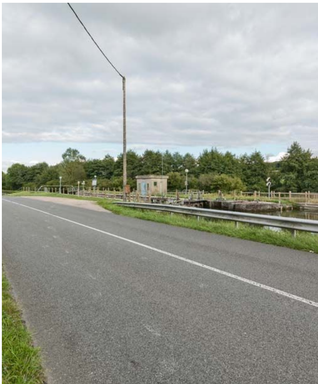
Vue d'ensemble du site d'écluse.
