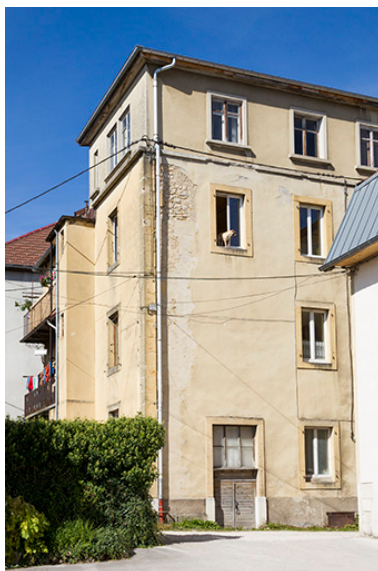
Façades latérale gauche et postérieure. Phot. Yves Sancey IVR43_20132502202NUC2A
