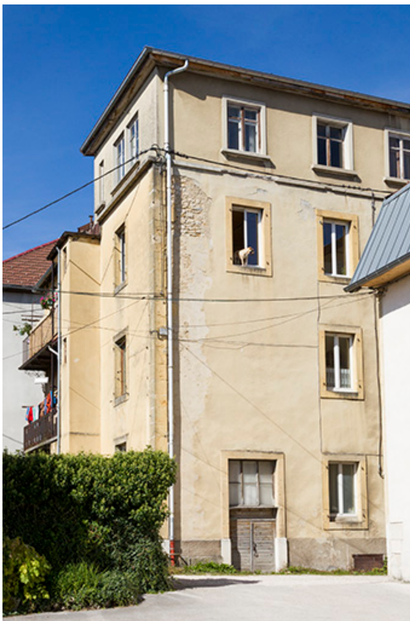
Façades latérale gauche et postérieure.
