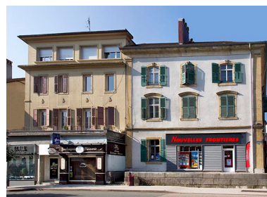
Façade des immeubles aux n° 19 et 21 Grande Rue. Phot. Yves Sancey IVR43_20132502262NUC2A
