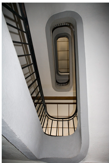
Cage d'escalier : escalier vu en contre-plongée. Phot. Yves Sancey IVR43_20062500565NUCA
