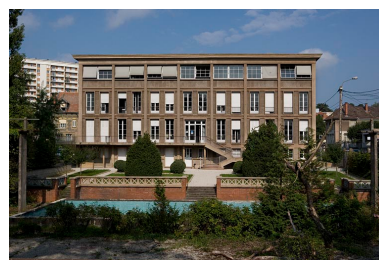
Face latérale gauche, depuis le jardin. Phot. Yves Sancey IVR43_20062500551NUCA
