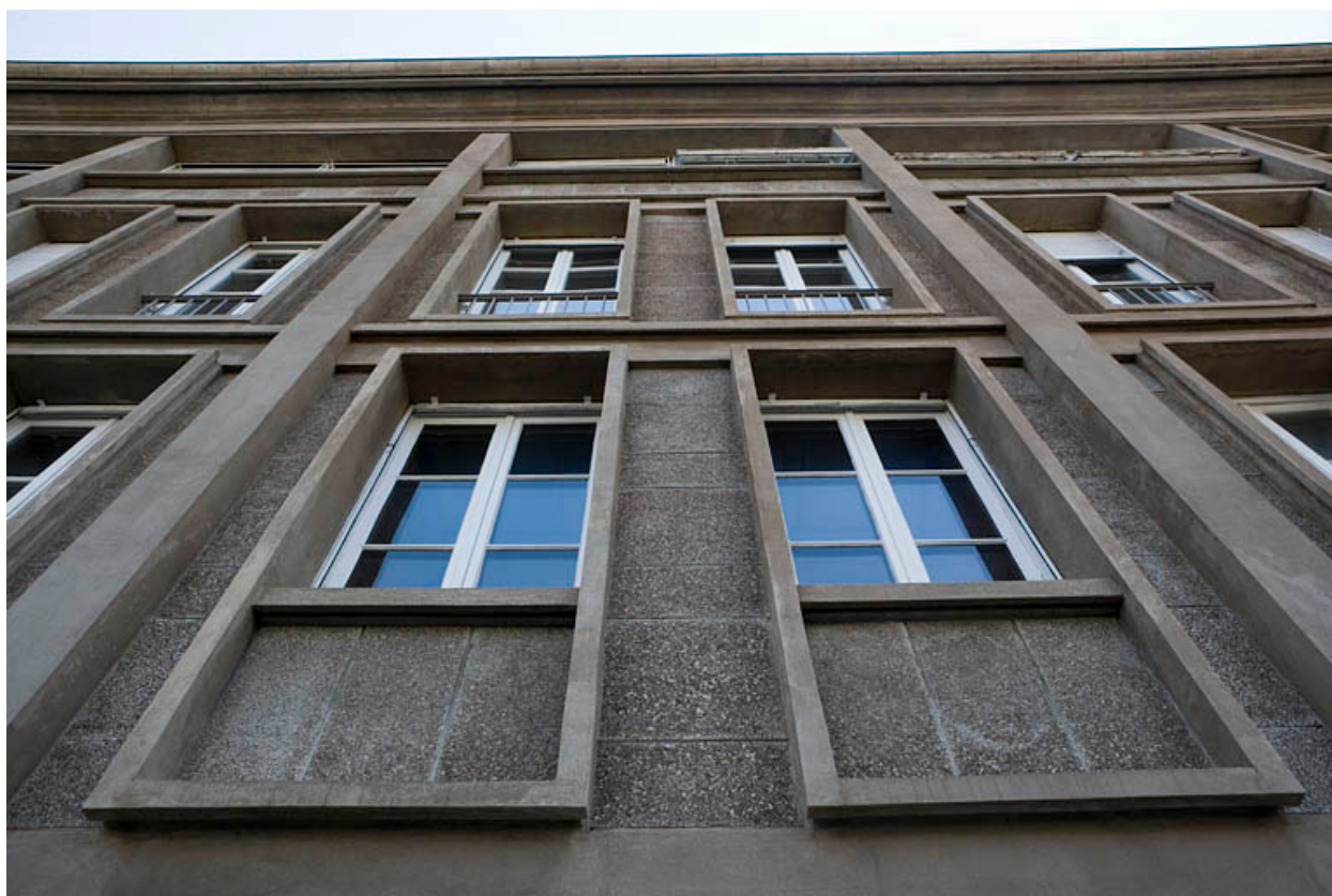
Face latérale droite : fenêtres vues en contre-plongée.
