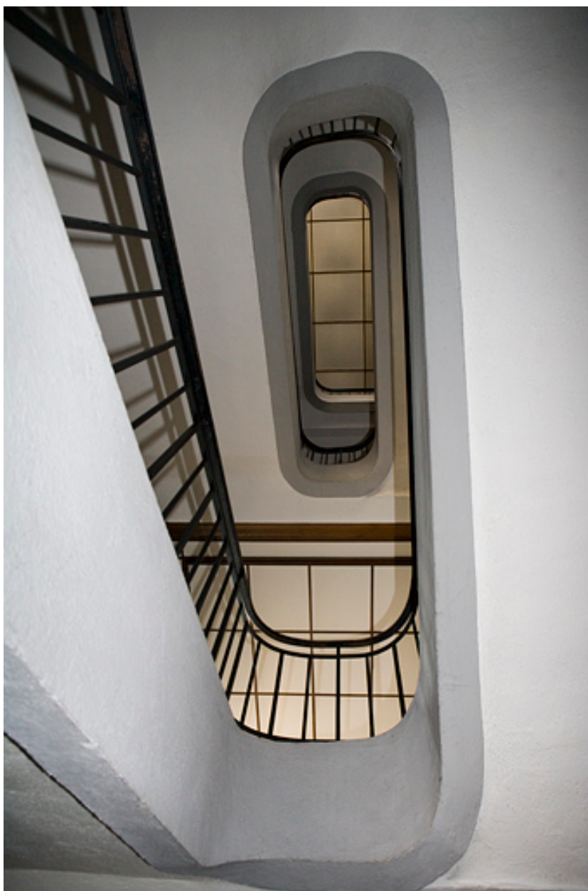
Cage d'escalier : escalier vu en contre-plongée.
