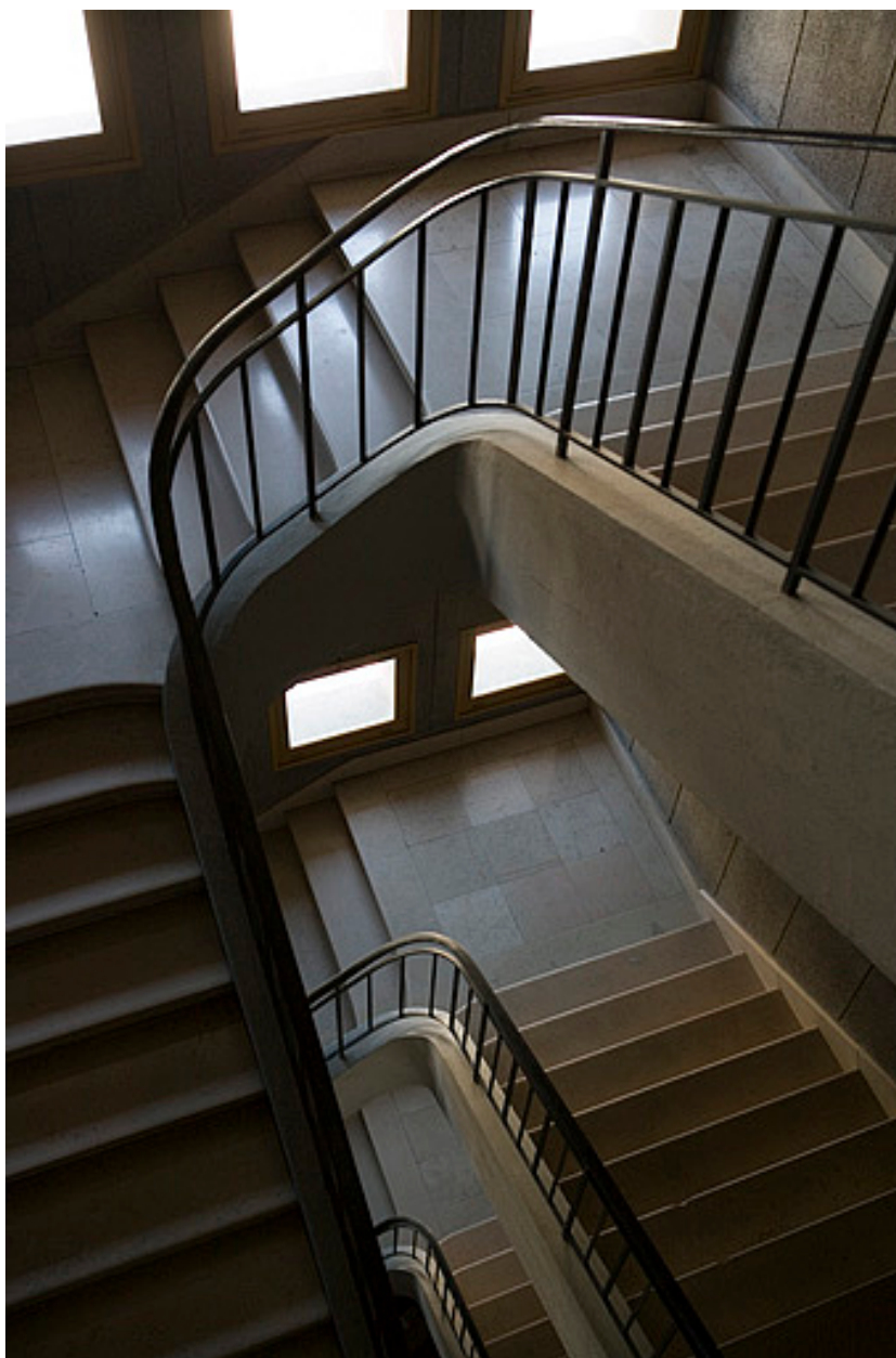
Cage d'escalier : escalier vu en plongée.
