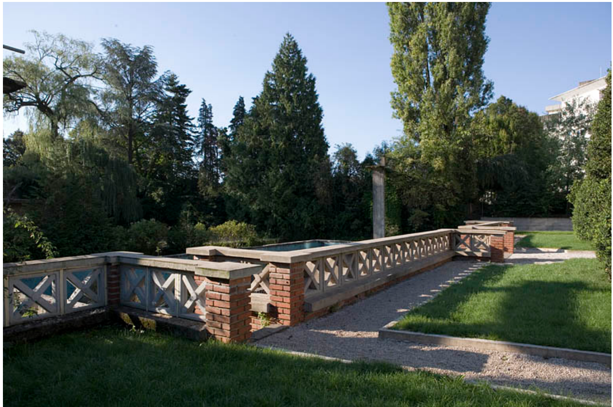
Jardin : garde-corps, du côté de l'usine.
