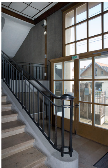
Cage d'escalier : hall et départ de la première volée de marches. Phot. Yves Sancey IVR43_20062500563NUCA
