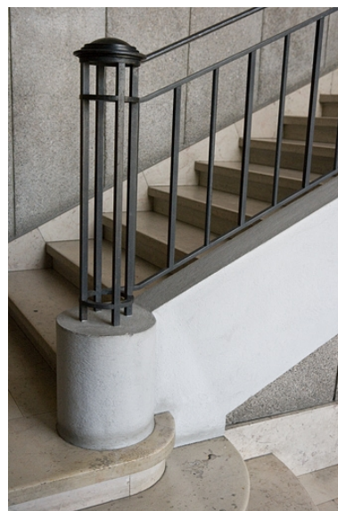
Cage d'escalier : départ de la rampe. Phot. Yves Sancey IVR43_20062500562NUCA
