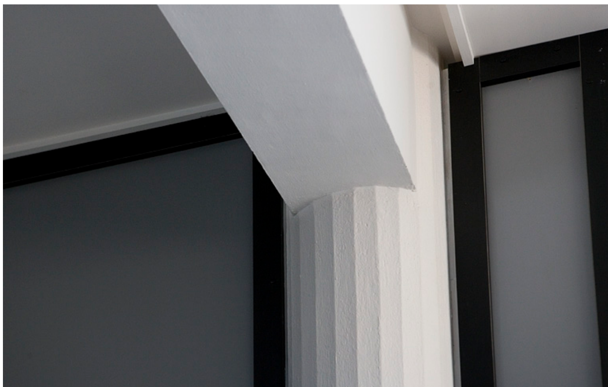
Premier étage : détail de la jonction d'un pilier et d'une poutre.
