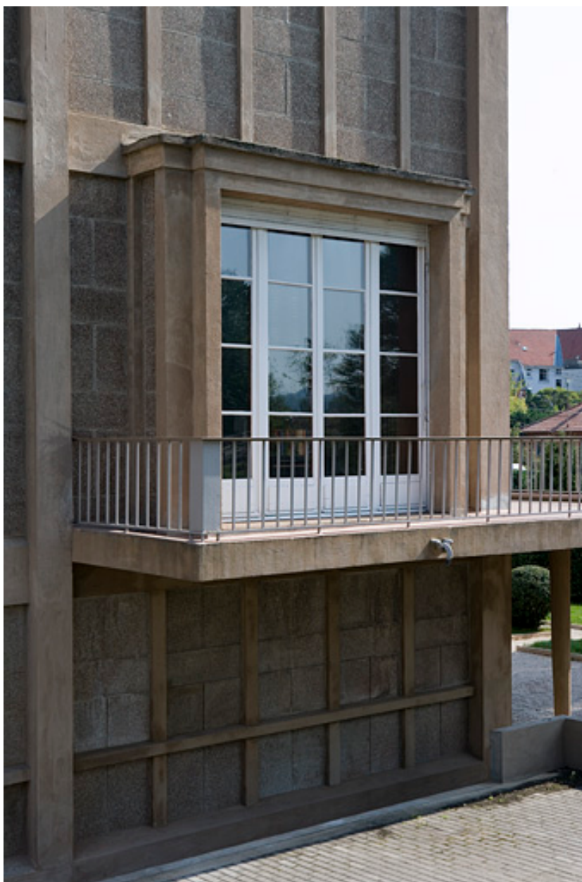
Façade postérieure : porte-fenêtre.
