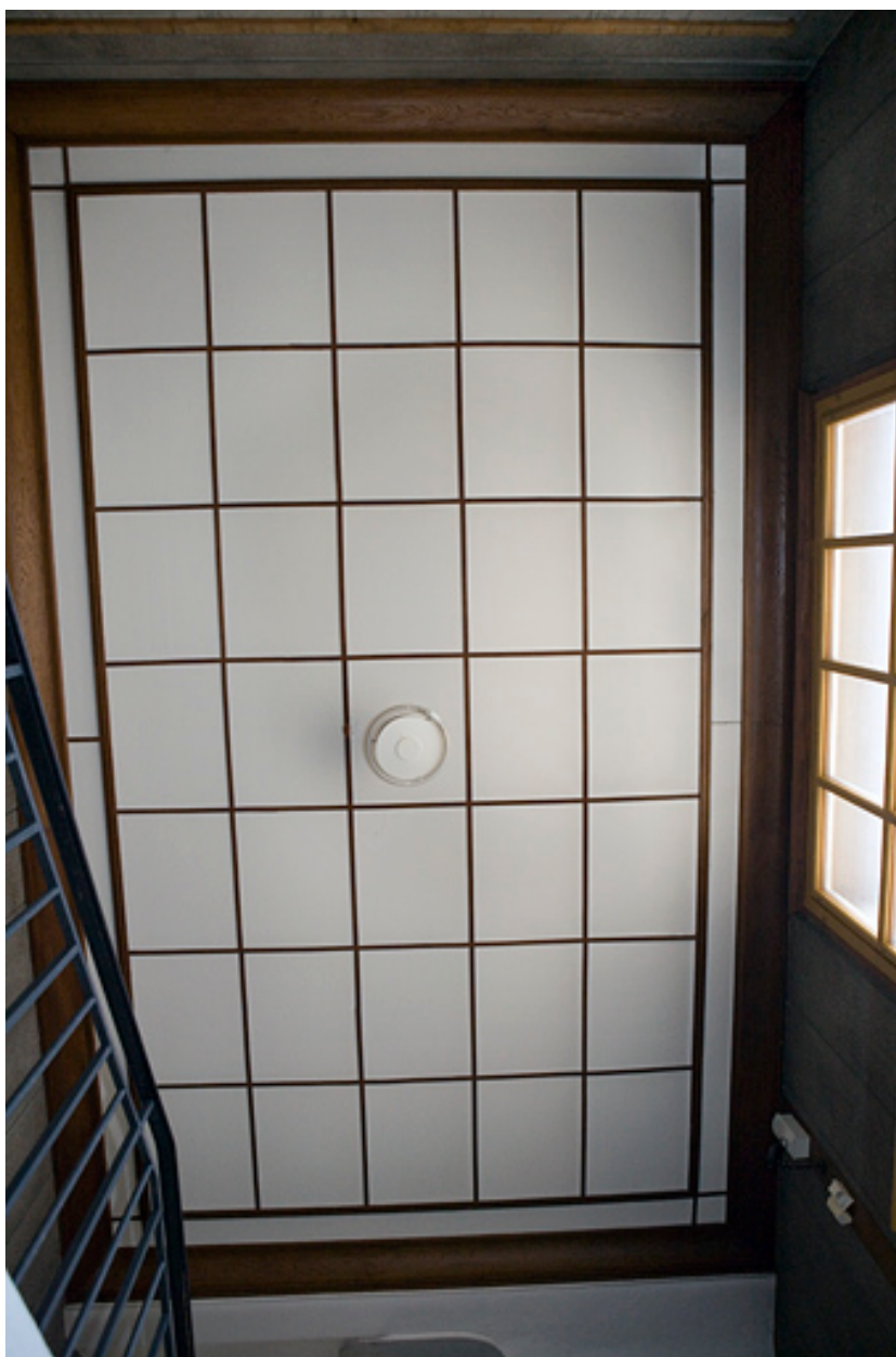
Cage d'escalier : plafond du hall.
