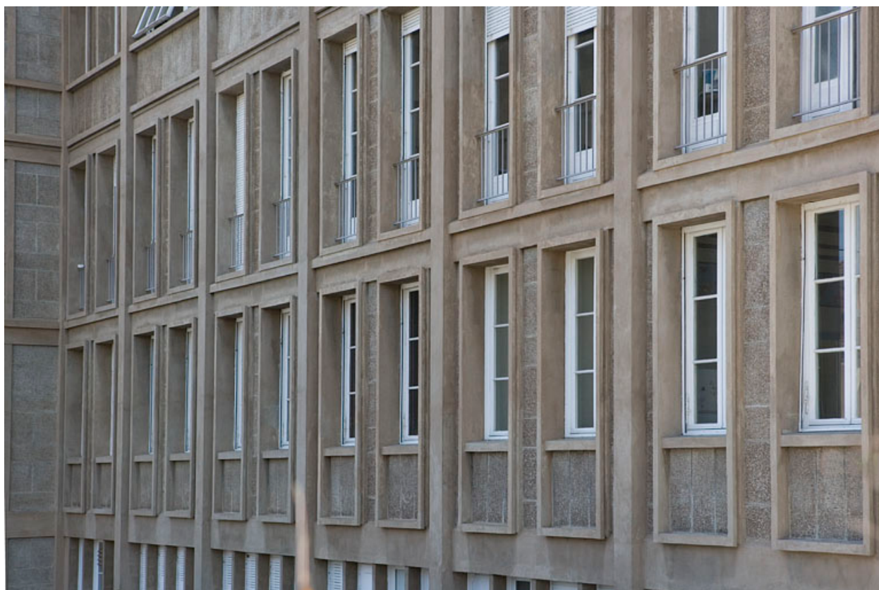
Face latérale droite : fenêtres vues en enfilade.
