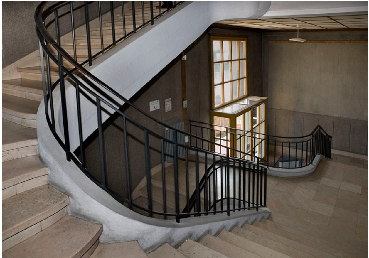
Cage d'escalier : vue d'ensemble du hall et de l'escalier, depuis la deuxième volée de marches.
