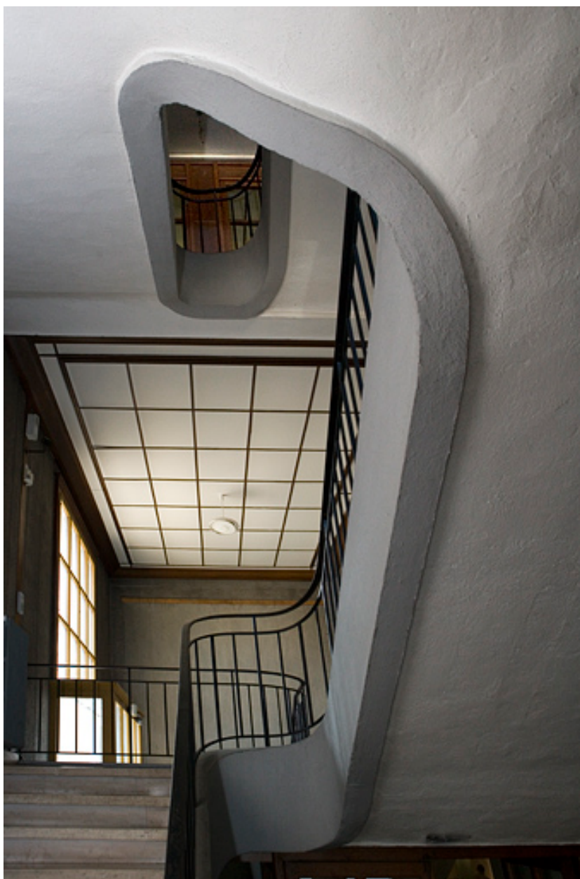
Cage d'escalier : vue d'ensemble du hall et de l'escalier, depuis la volée de marches inférieure.
