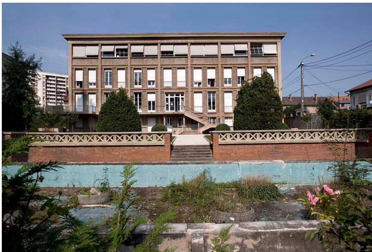
Piscine : vue d'ensemble, avec l'usine en arrière-plan.
