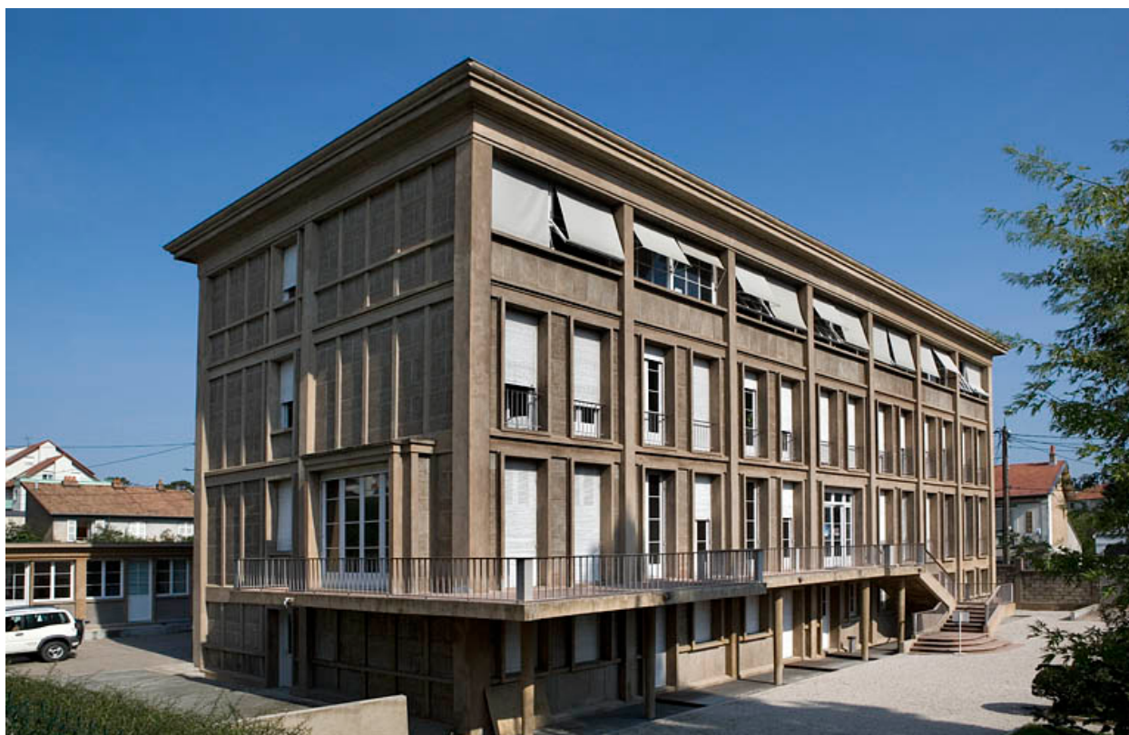
Façades postérieure et latérale gauche.
