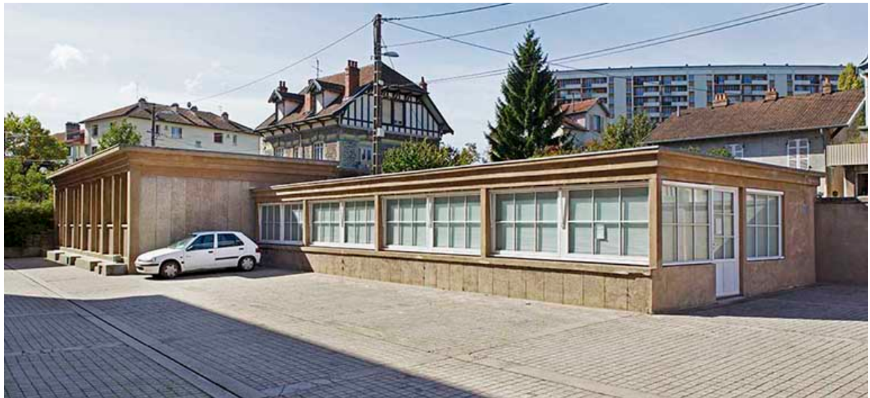
Garages : façades antérieure et latérale droite.
