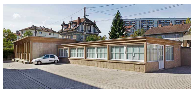
Garages : façades antérieure et latérale droite. Phot. Sonia Dourlot IVR43_20142501401NUC2A
