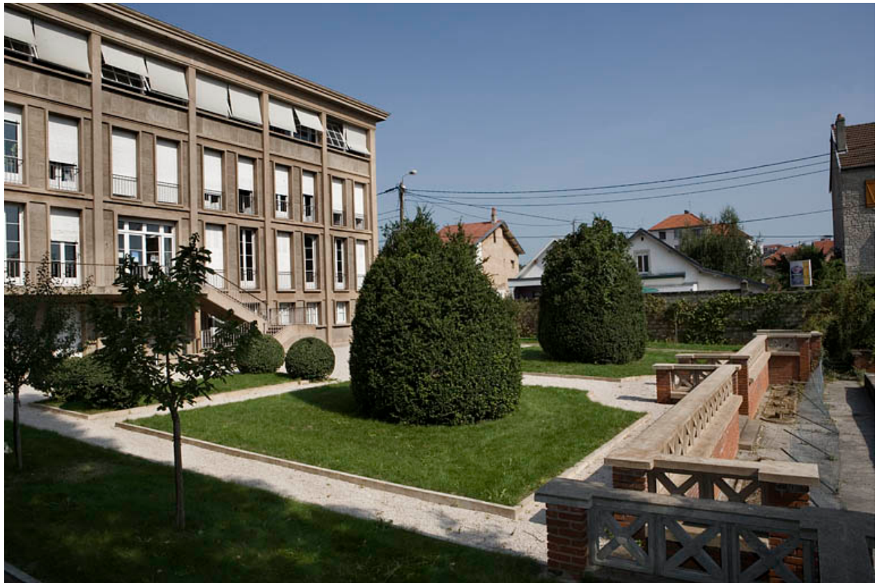
Jardin et face latérale gauche de l'usine.
