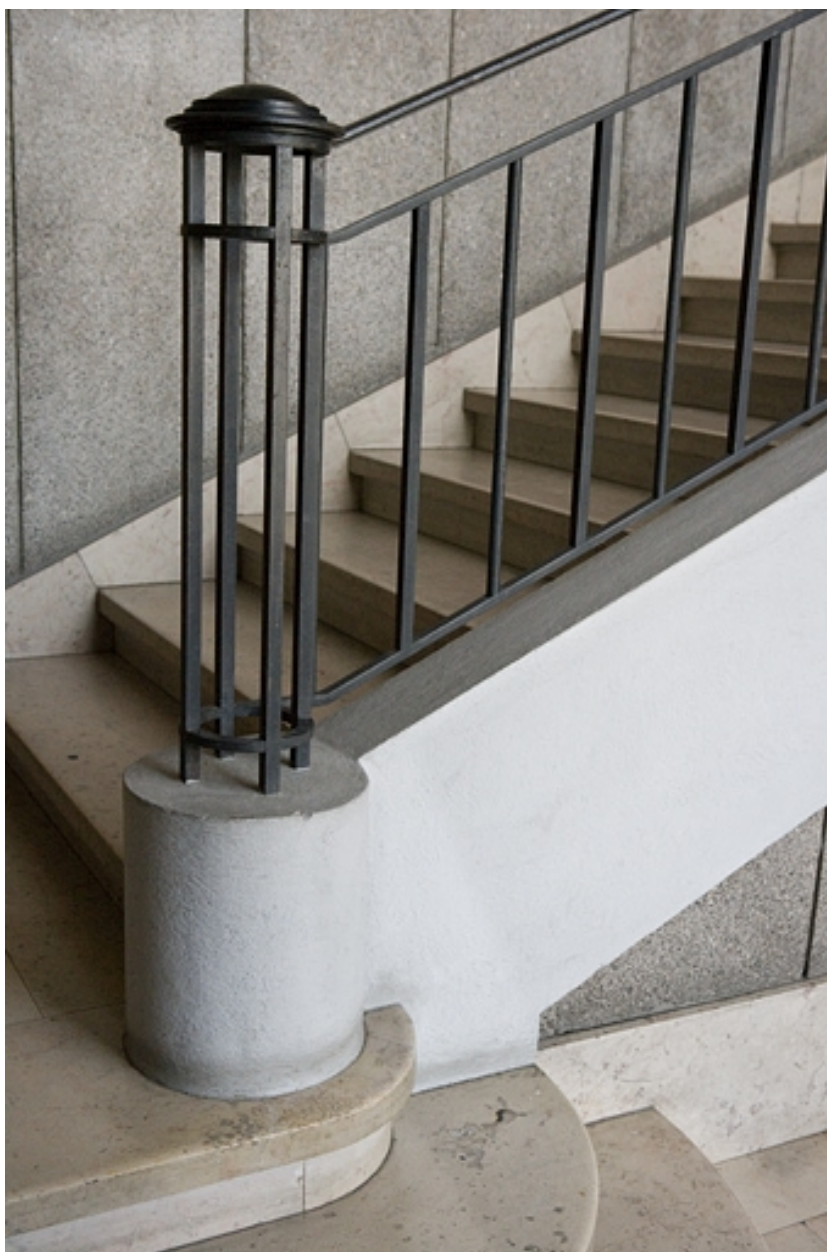
Cage d'escalier : départ de la rampe.
