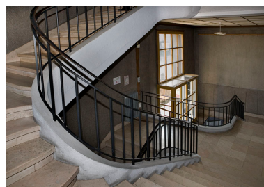
Cage d'escalier : vue d'ensemble du hall et de l'escalier, depuis la deuxième volée de marches. Phot. Yves Sancey IVR43_20062500561NUCA
