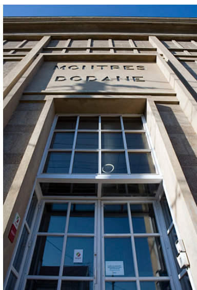
Façade antérieure : entrée vue en contre-plongée. Phot. Yves Sancey IVR43_20062500589NUCA
