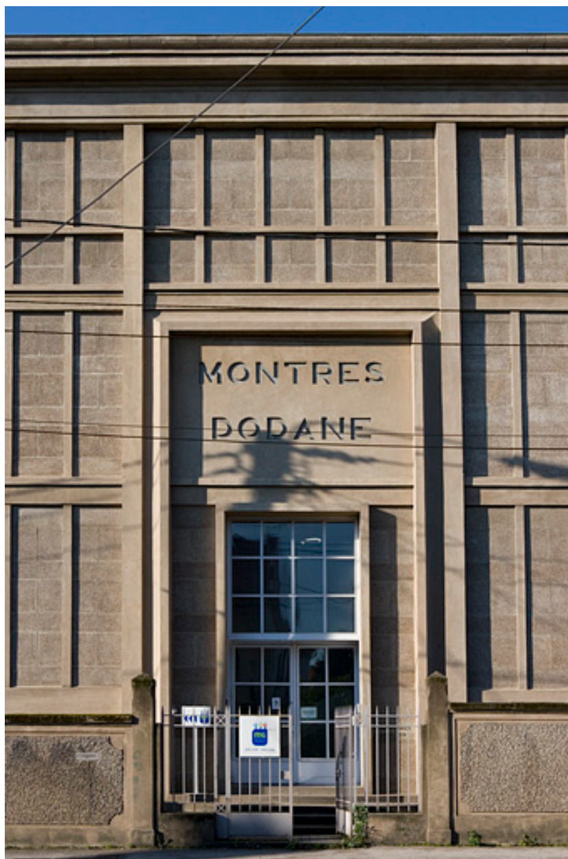
Façade antérieure : travée centrale.
