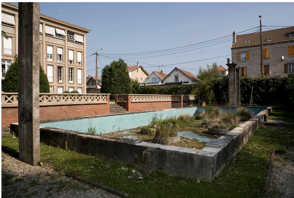
Piscine : vue de trois quarts.
