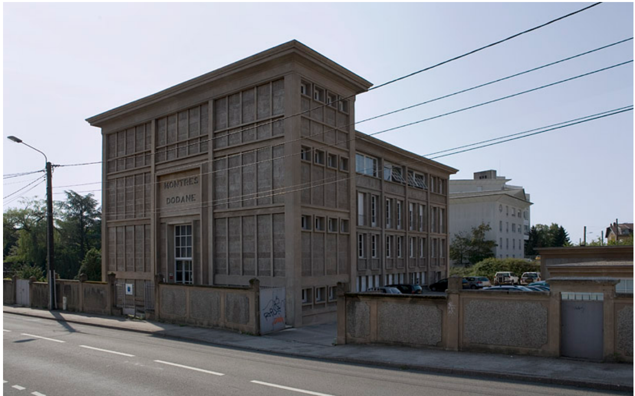
Façades antérieure et latérale droite.
