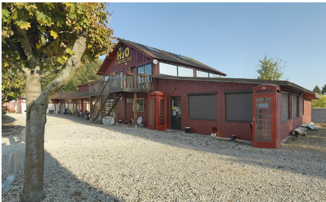
Remise transformée en capitainerie H2O.
