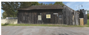
Remise conservée et traitée au grésil. Phot. Thierry Kuntz IVR26_20112103394NUC4AQ
