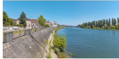
Le quai vu d'aval.
