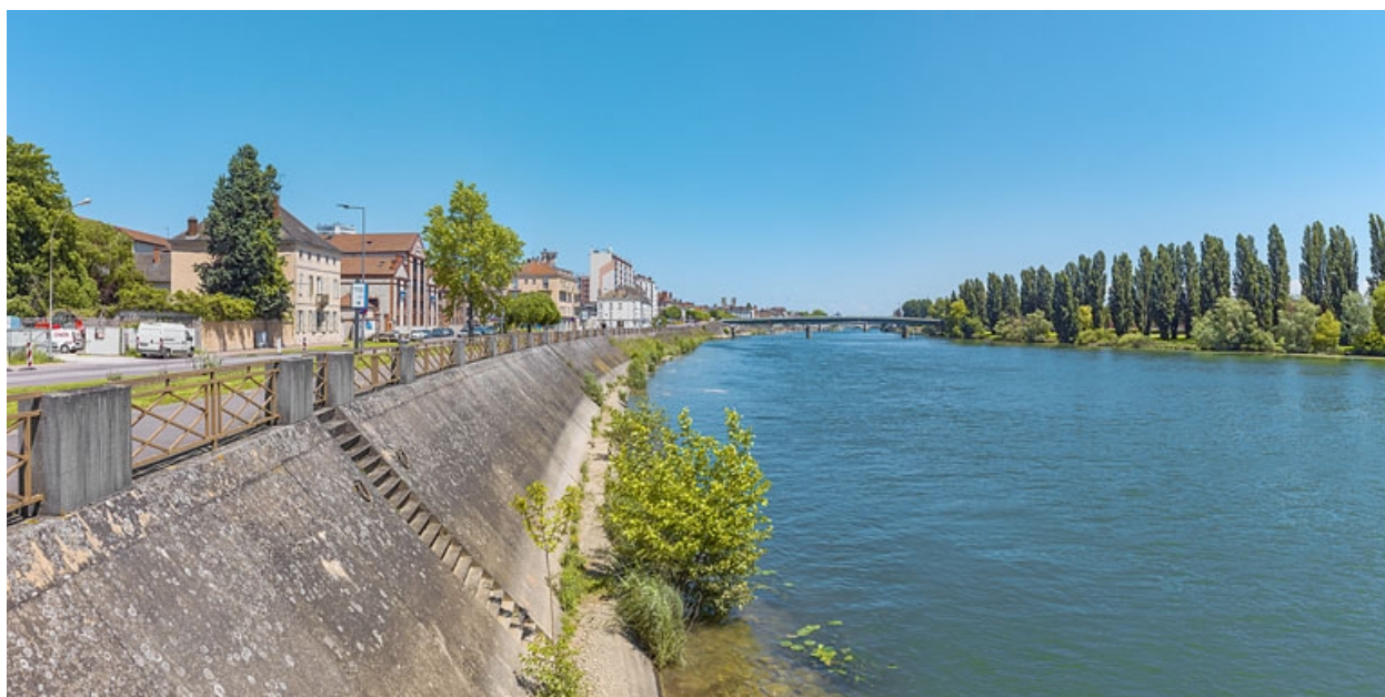
Le quai vu d'aval.
