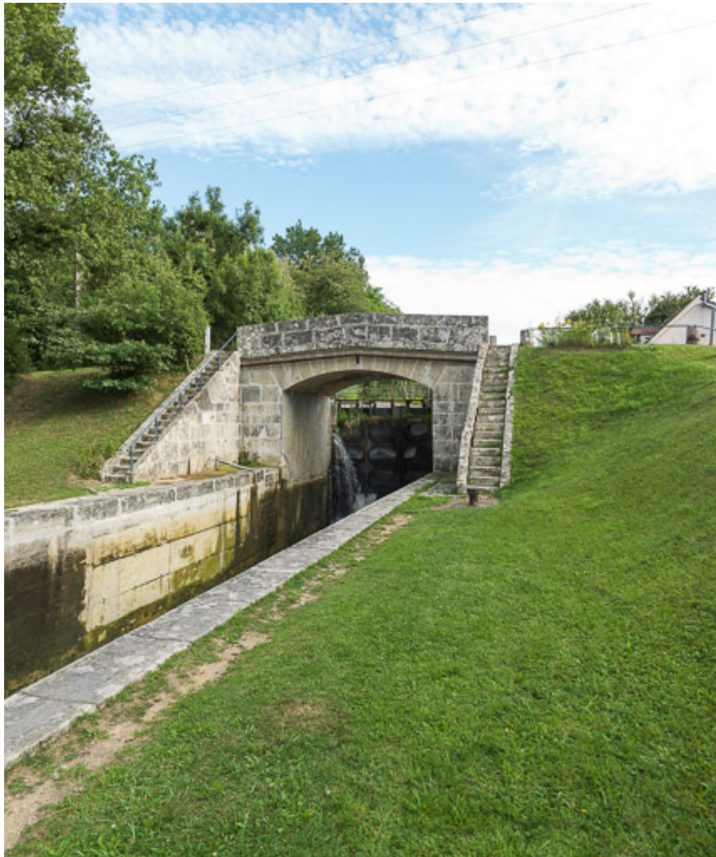
Vue d'ensemble du pont.
