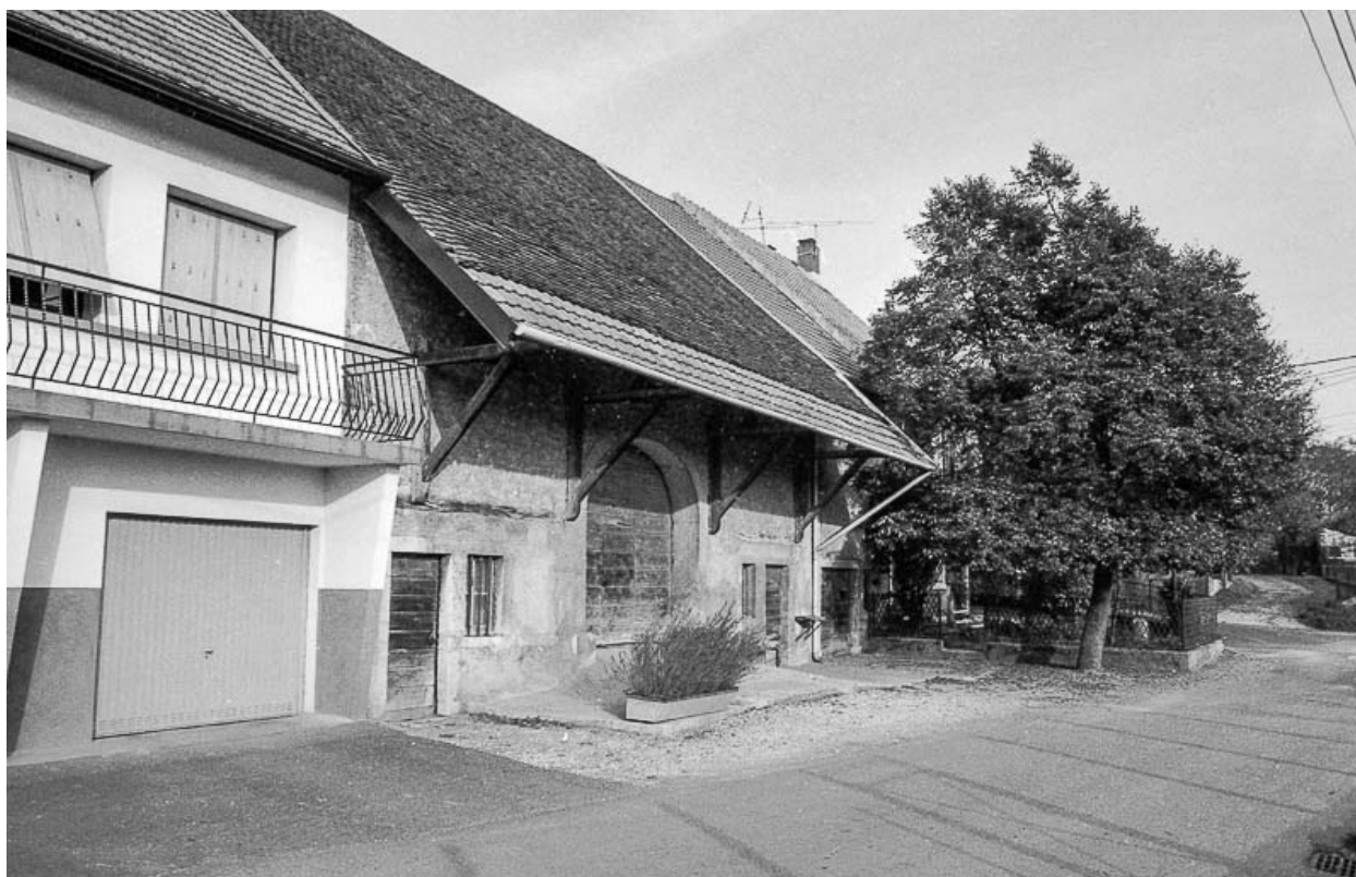
Ferme située rue des Roches.
