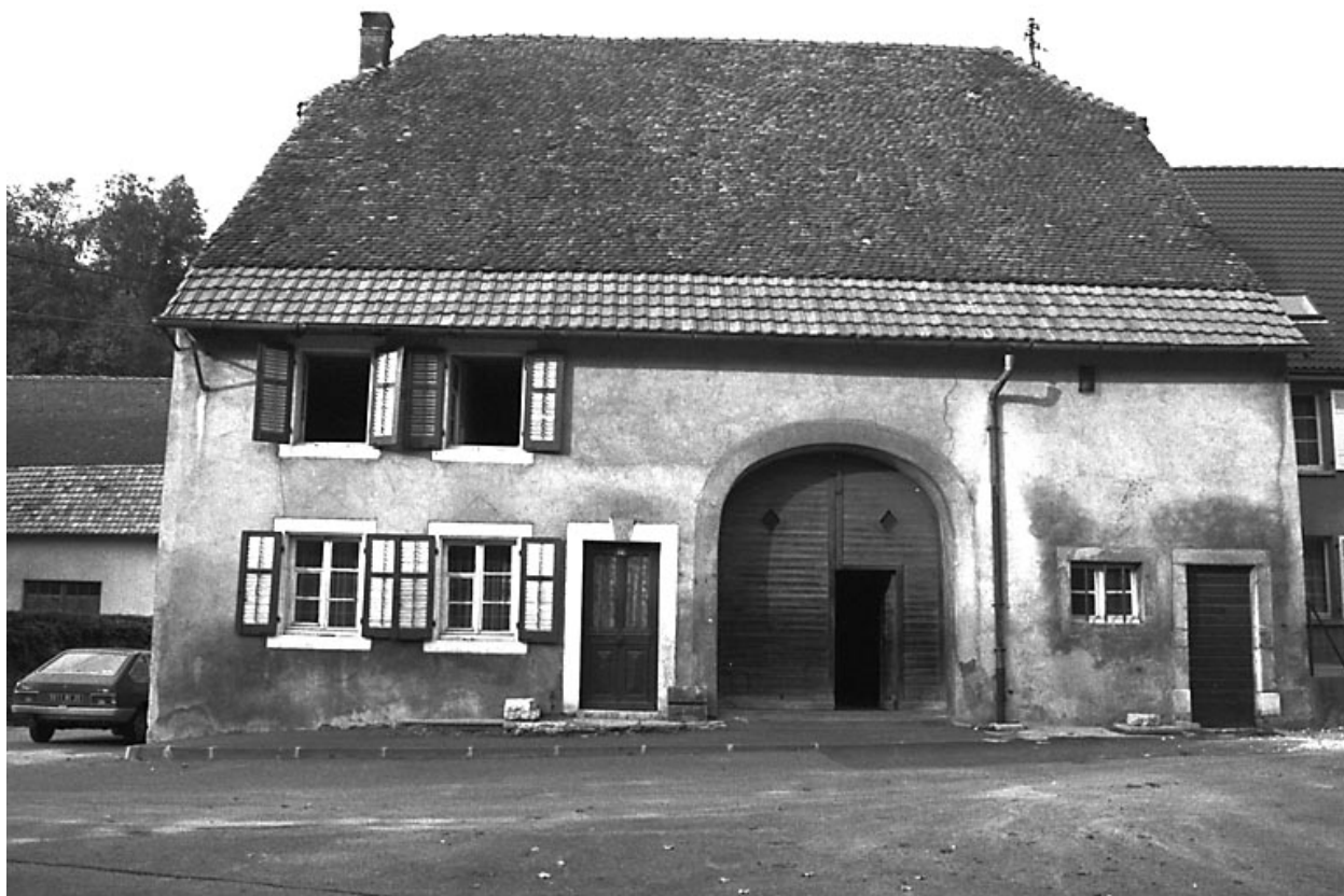
Ferme située rue du Château d'Eau.
