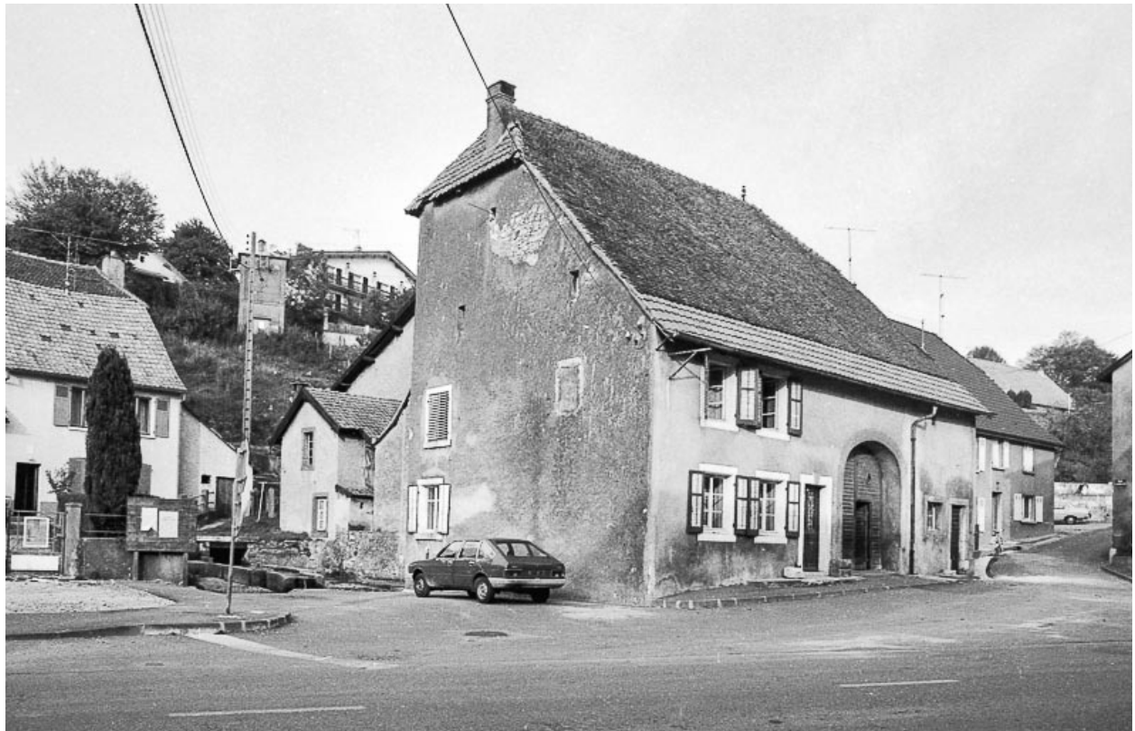
Ferme située rue du Château d'Eau.
