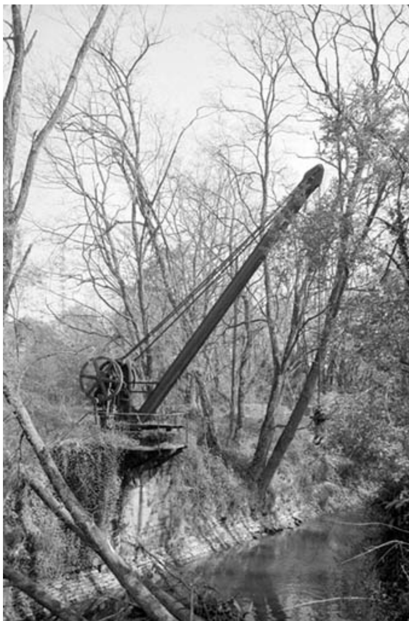
Forge Neuve. Le port : grue (M).
