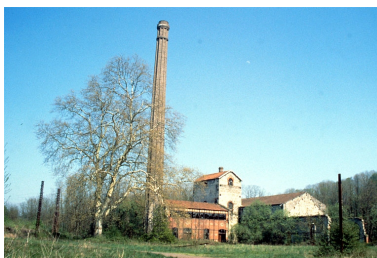
Forge Neuve. Centrale électrique, monte-charge du haut-fourneau et fonderie.
