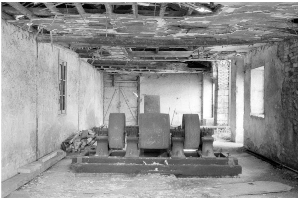
Vieille Forge. Bâtiment d'eau dit le Sénat : intérieur.
