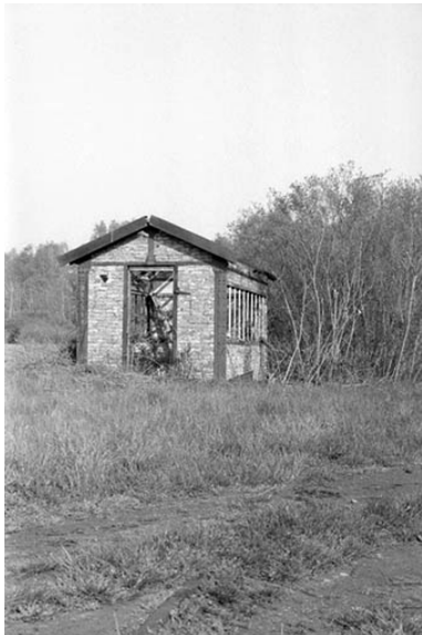
Forge Neuve. Bâtiment (Q) : pont-bascule ? Phot. Laurent Poupard IVR43_19883900319Z
