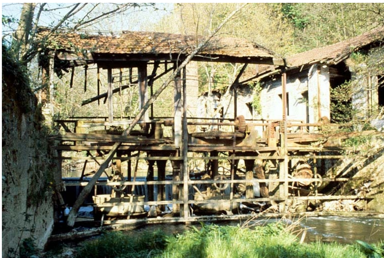
Vieille Forge. Bâtiment d'eau dit le Sénat : salle des turbines vue du canal de fuite.
