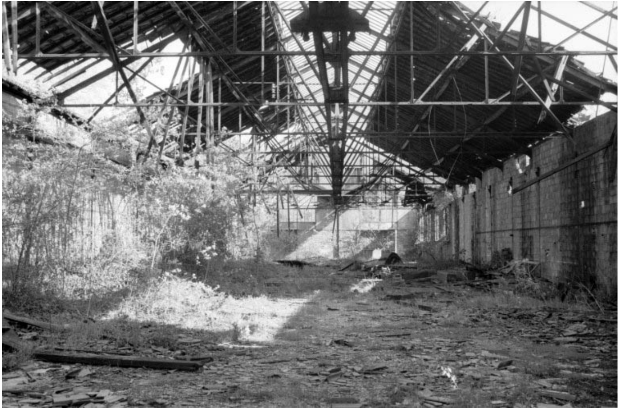
Forge Neuve. Atelier de construction : intérieur.
