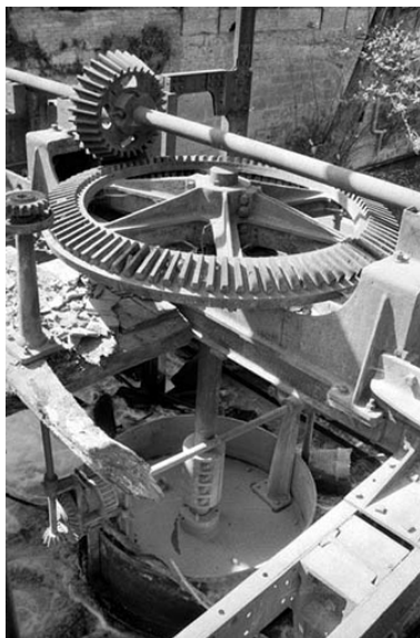
Vieille Forge. Bâtiment d'eau dit le Sénat : détail d'une turbine et de ses engrenages. Phot. Laurent Poupard IVR43_19883900328Z
