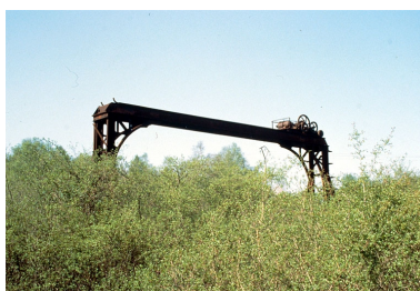
Forge Neuve. Portique roulant. Phot. Laurent Poupard IVR43_19883900321ZA
