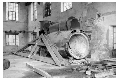
Forge Neuve. Centrale électrique : élément de fourneau (?) dans la salle des machines (H). Phot. Laurent Poupard IVR43_19883900307Z
