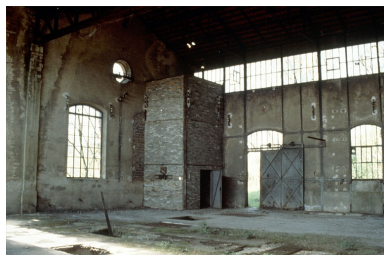
Forge Neuve. Centrale électrique : intérieur de la salle des machines (J). Phot. Laurent Poupard IVR43_19883900305ZA
