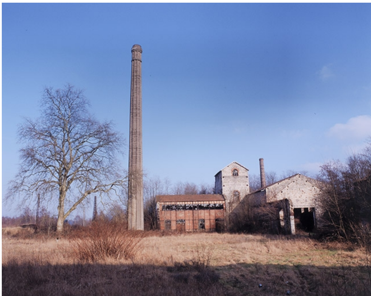
Forge Neuve. Centrale électrique, monte-charge du haut-fourneau et fonderie.
