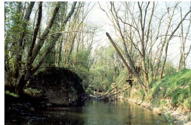
Forge Neuve. Le port (N) : entrée du canal. Phot. Laurent Poupard IVR43_19883900312ZA
