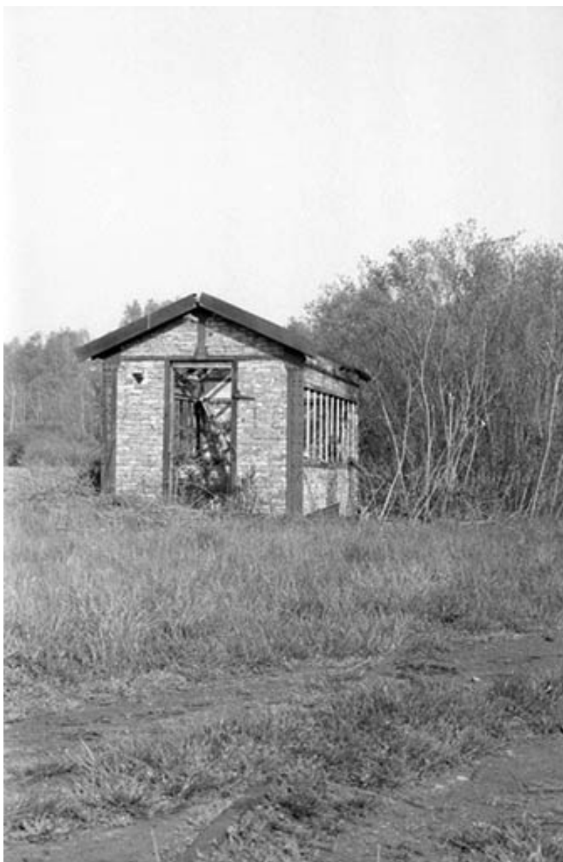
Forge Neuve. Bâtiment (Q) : pont-bascule ?
