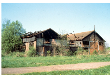
Forge Neuve. Atelier de construction : façade antérieure. Phot. Laurent Poupard IVR43_19883900314ZA
