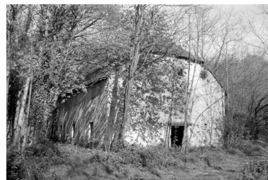
Vieille Forge. Logement d'ouvriers (B) vu de trois quarts gauche. Phot. Laurent Poupard IVR43_19883900329Z
