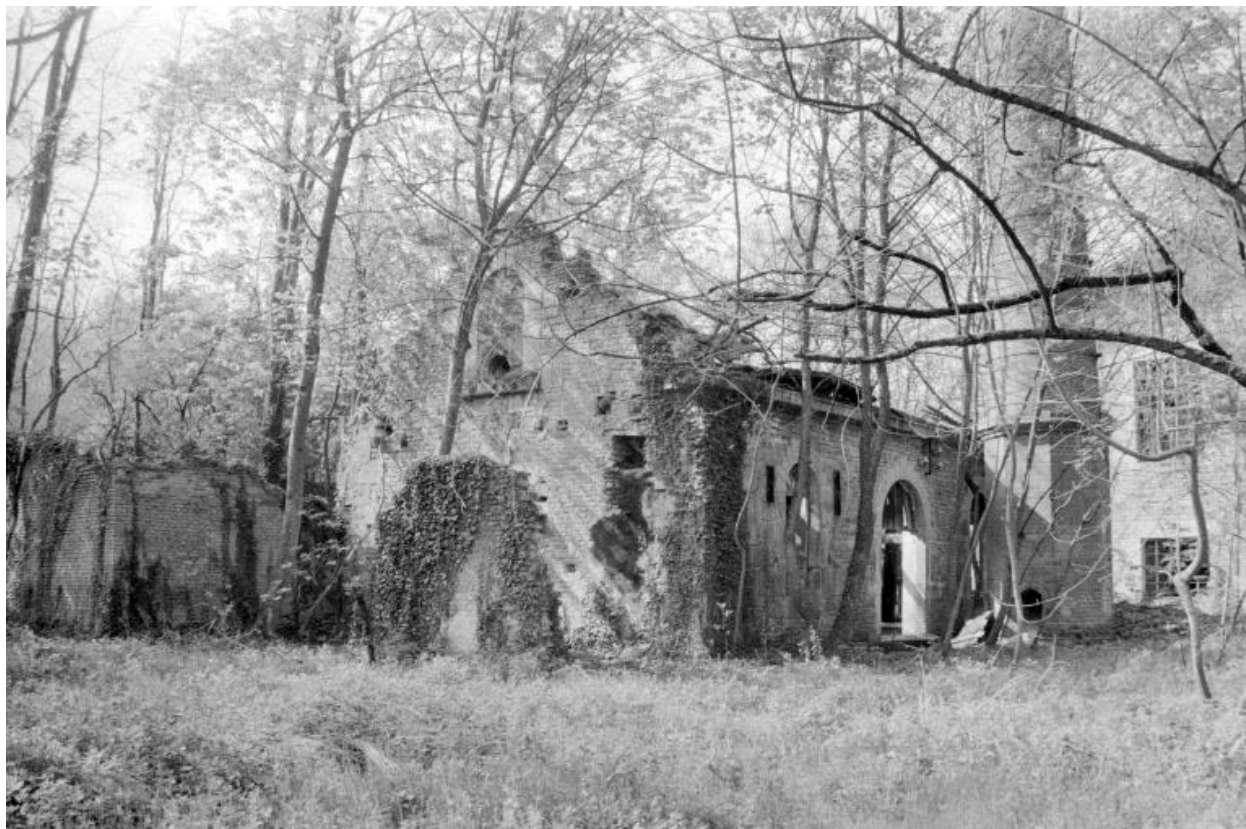
Forge Neuve. Bâtiment d'eau (L) vu de trois quarts gauche.
