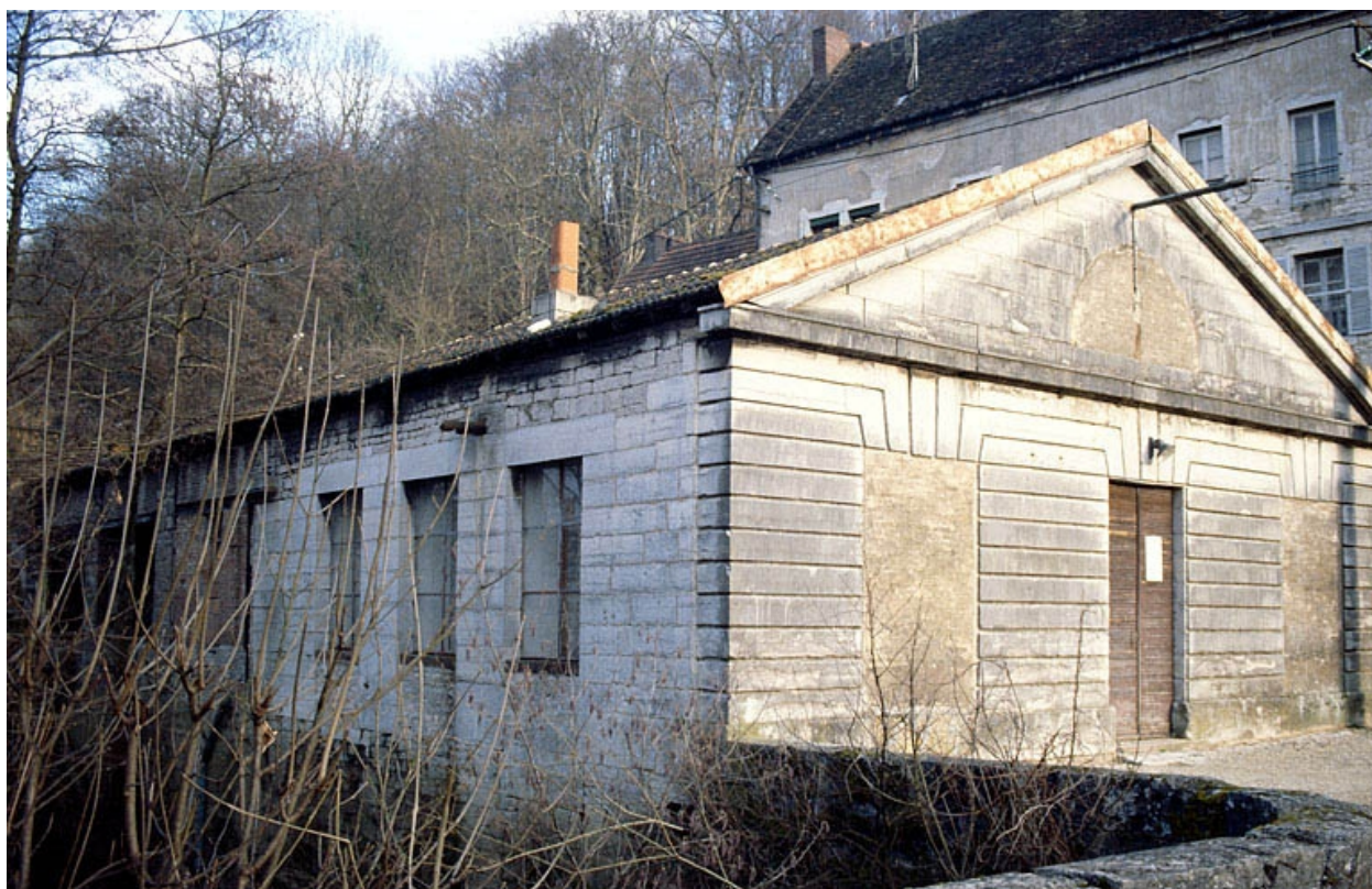
Vieille Forge. Bâtiment d'eau dit le Sénat vu de trois quarts gauche.
