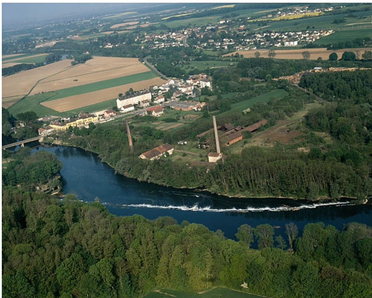
La Forge Neuve vue de l'est, photographie aérienne.
