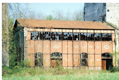
Forge Neuve. Centrale électrique : façade antérieure de la salle des machines (J). Phot. Laurent Poupard IVR43_19883900308ZA
