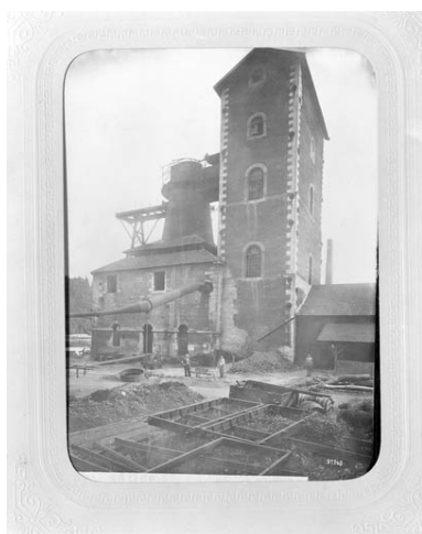
Le haut-fourneau vu du nord, à la fin du 19e siècle. Phot. Yves Sancey, Phot. De Jongh Frères IVR43_19883900214V
