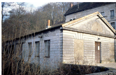
Vieille Forge. Bâtiment d'eau dit le Sénat vu de trois quarts gauche. Phot. Laurent Poupard IVR43_19883900325ZA
