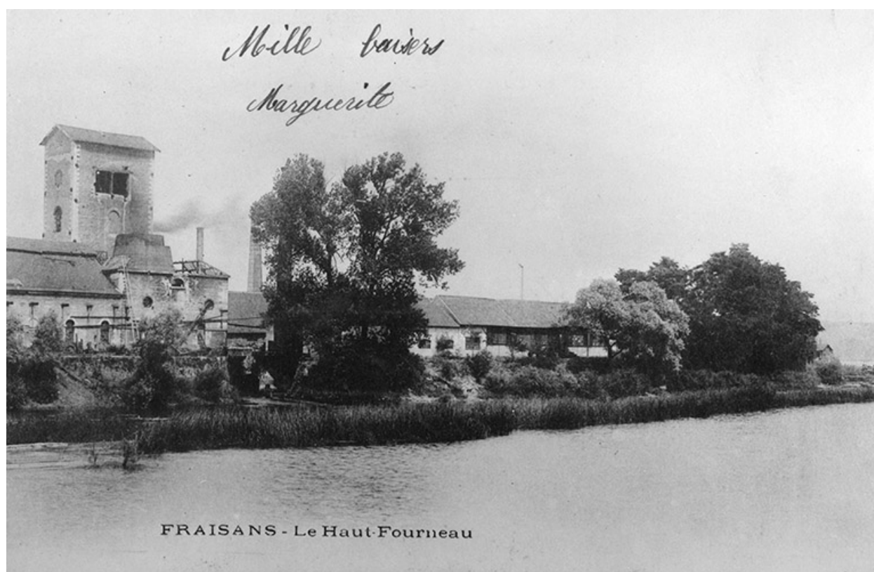
Fraisans. Le Haut-Fourneau vu du sud-est.
