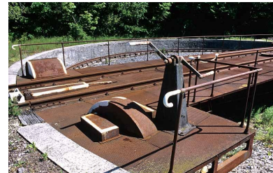
Poste de manoeuvre. Phot. Yves Sancey IVR43_20053900005ZA
