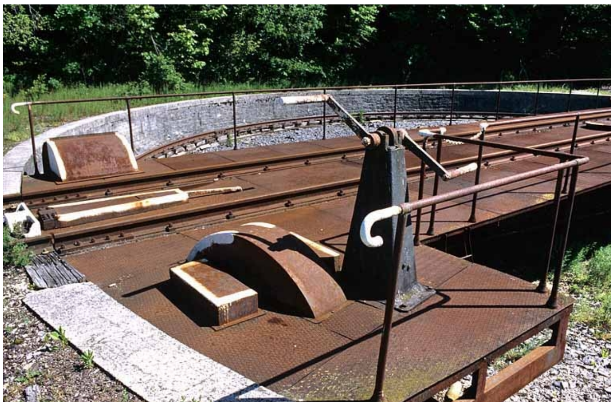
Poste de manoeuvre.
