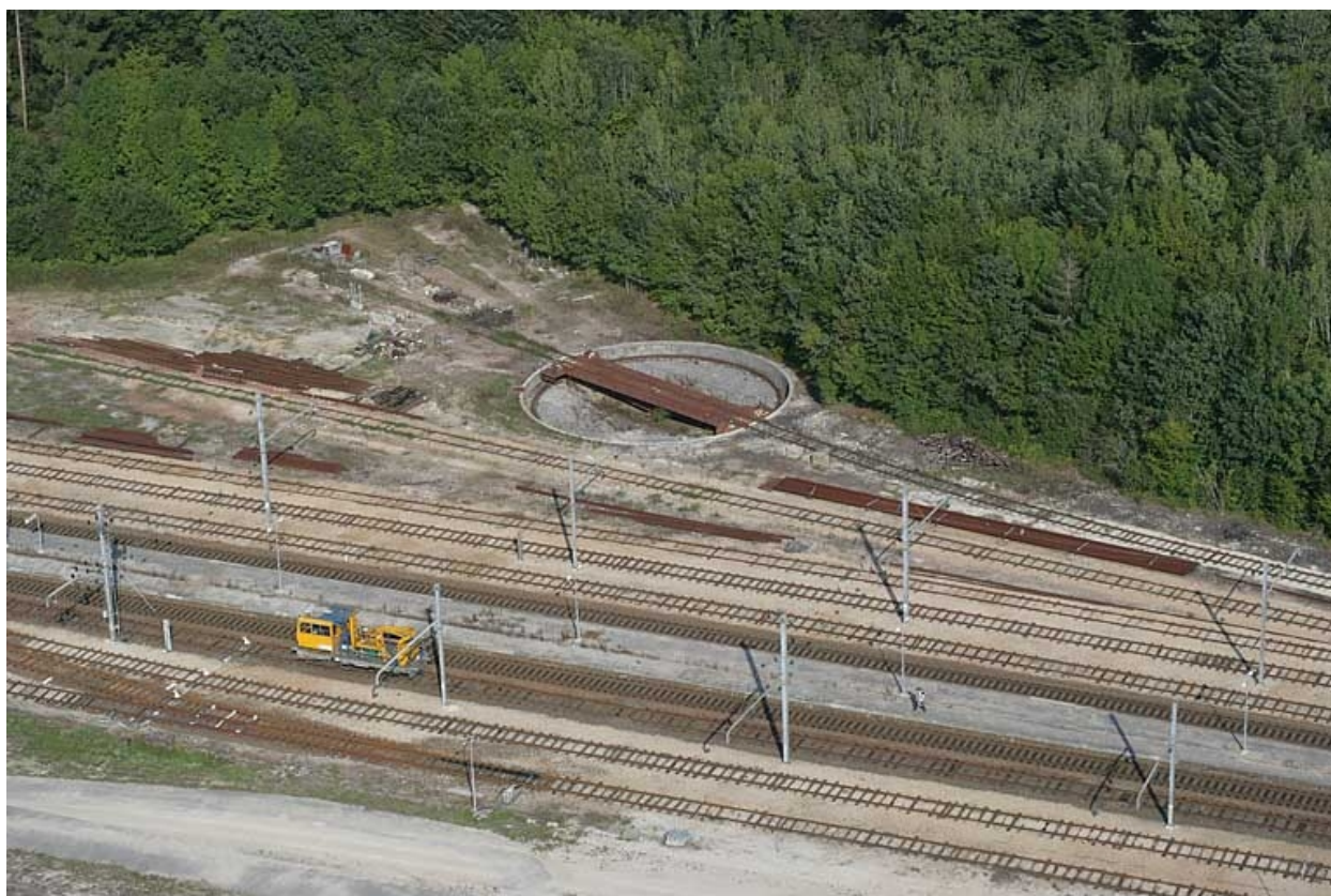
Vue aérienne, depuis l'est.
