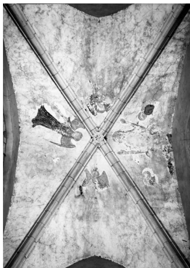
Vue générale Phot. Michel Rosso IVR26_19852101770V
