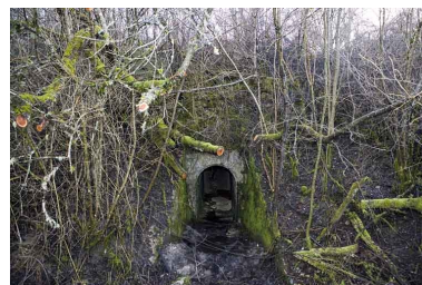
Réservoir, Pâturage de Montsevely : aqueduc d'évacuation. Phot. Yves Sancey IVR43_20073900032NUCA
