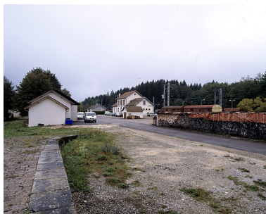
Vue d'ensemble, depuis le nord- est (cour des marchandises). Phot. Yves Sancey IVR43_20043900088XA
