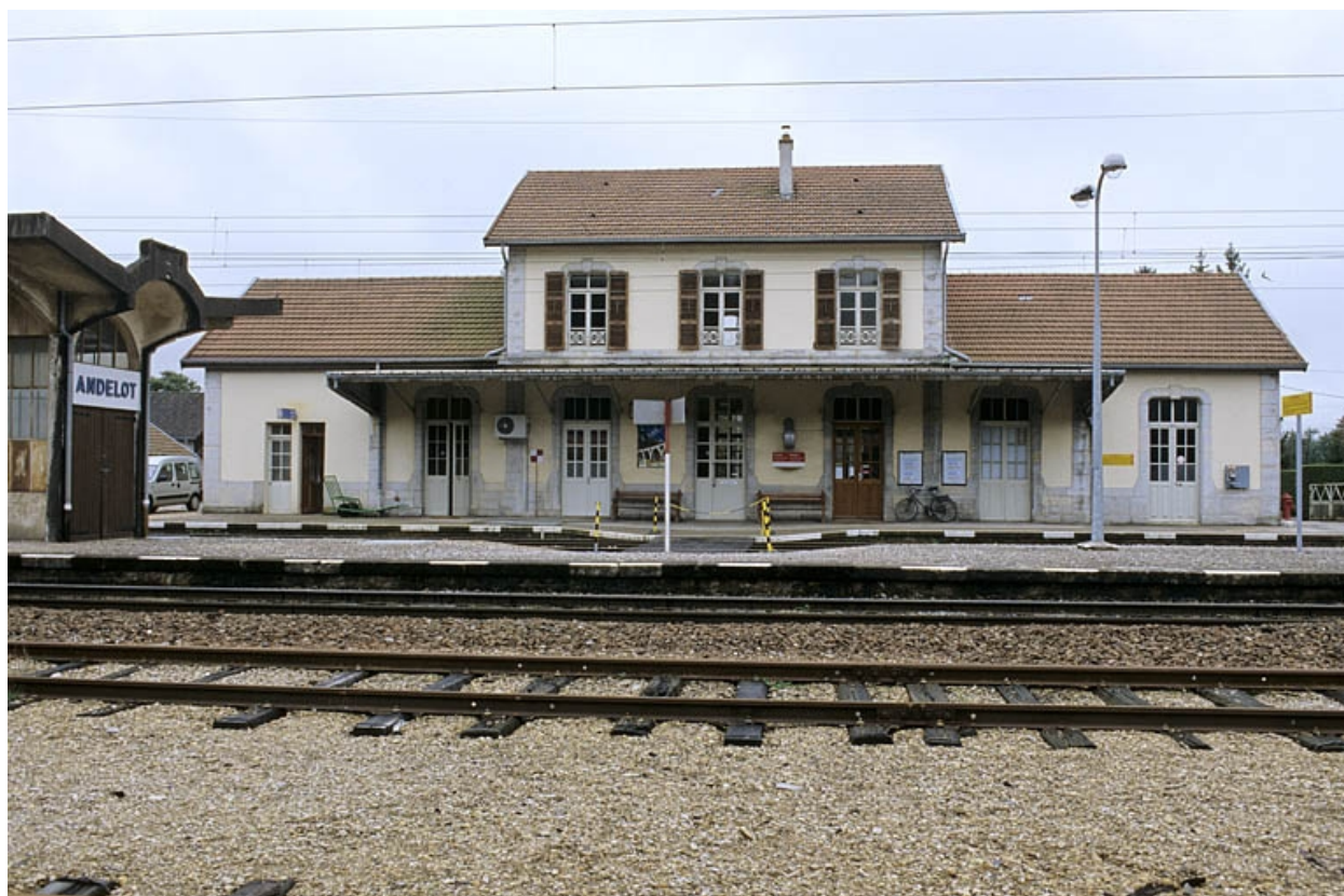
Bâtiment des voyageurs : façade postérieure, de face.
