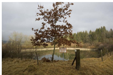
Réservoir, Pâturage de Montsevely : vue d'ensemble. Phot. Yves Sancey IVR43_20073900030NUCA
