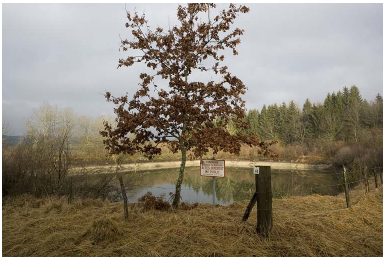
Réservoir, Pâture de Montsevely : vue d'ensemble.
