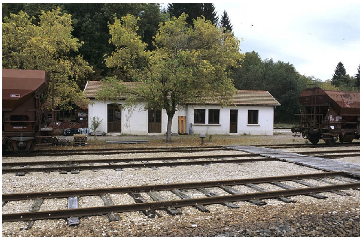
Ancienne lampisterie (bureau des électriciens), de face.
