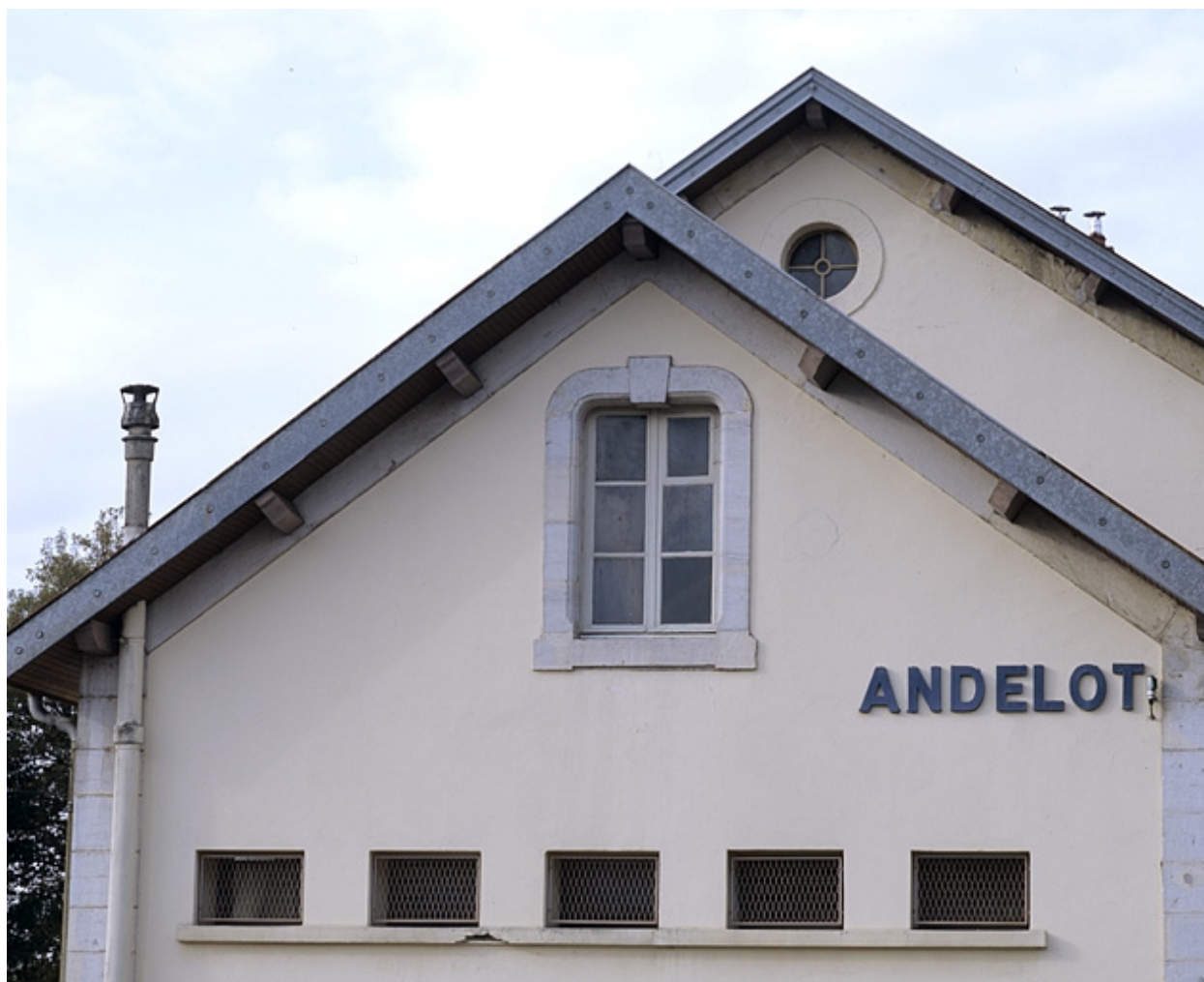
Bâtiment des voyageurs : pignon de l'aile droite.
