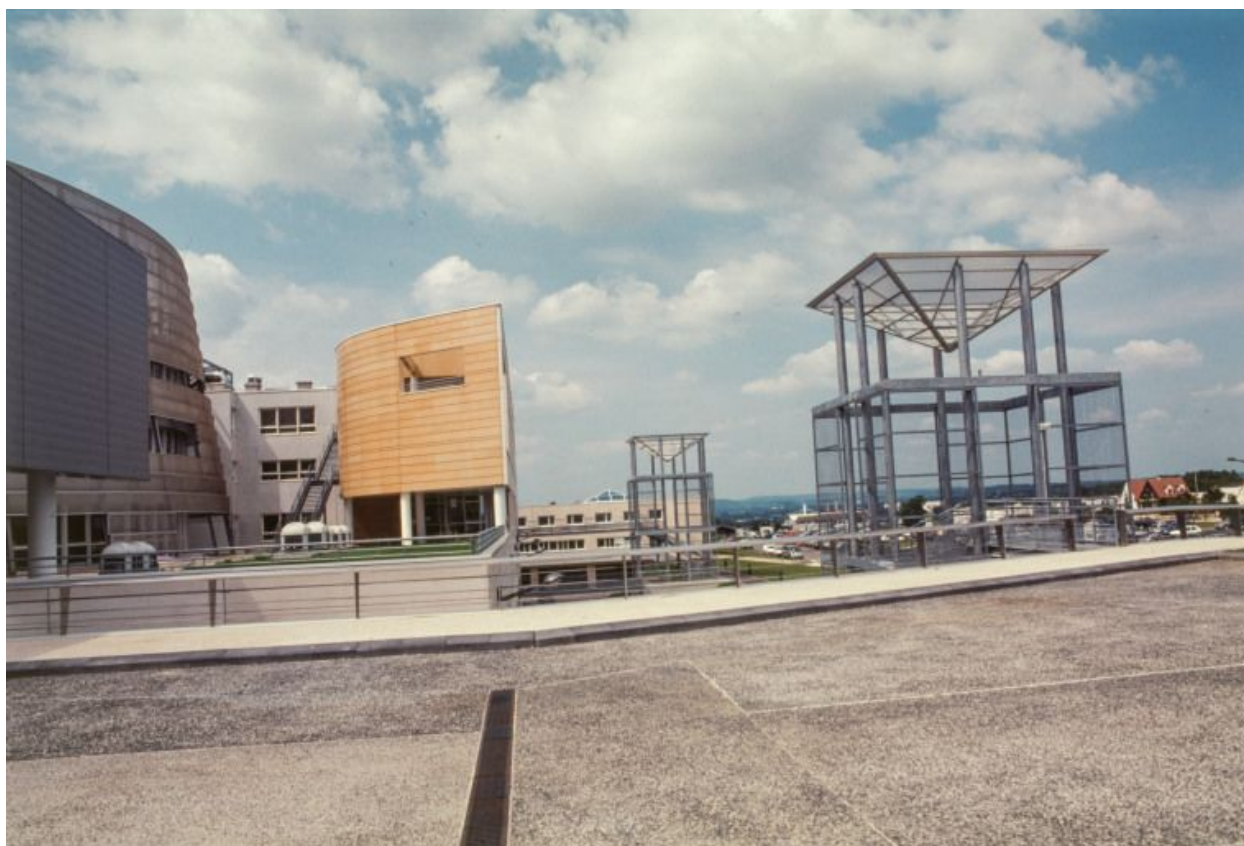
Façade postérieure, vue de la terrasse.
