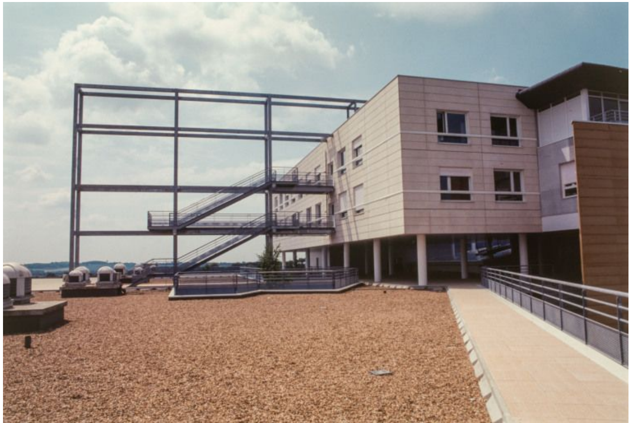
Façades antérieure et latérale.
