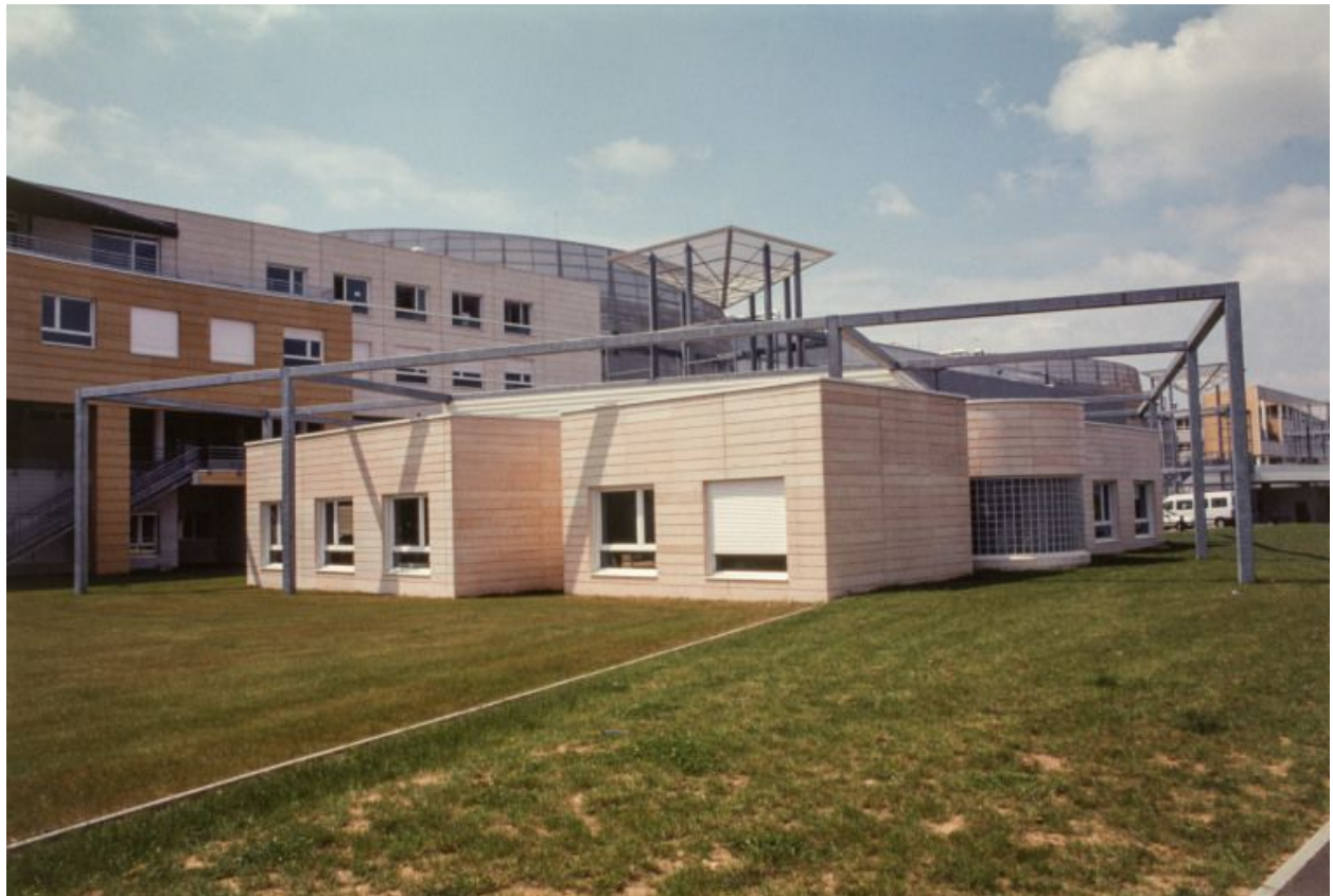
Bâtiment de l'administration.
