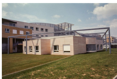
Bâtiment de l'administration. Phot. Jean-Luc Duthu IVR26_20035800200ZA
