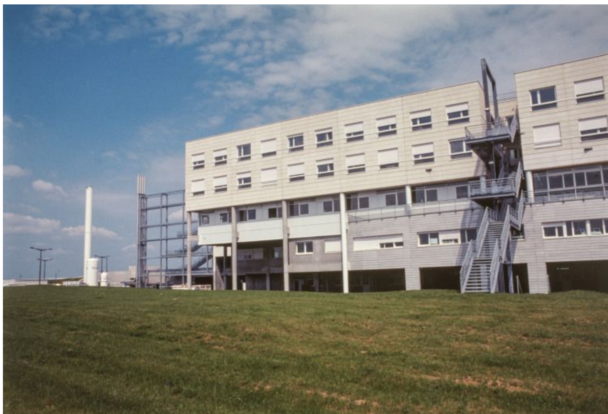
Façade postérieure, partie gauche.
