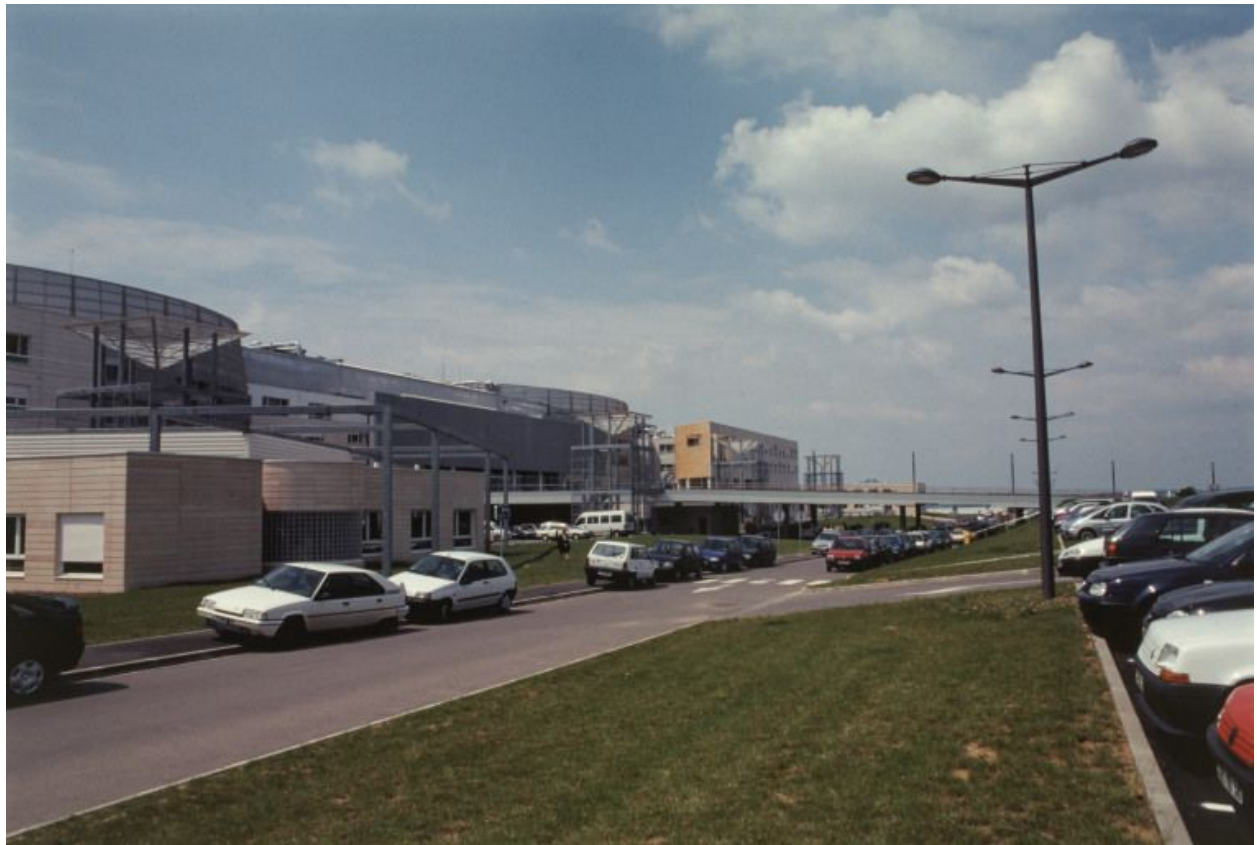
Façade antérieure, vue d'ensemble.
