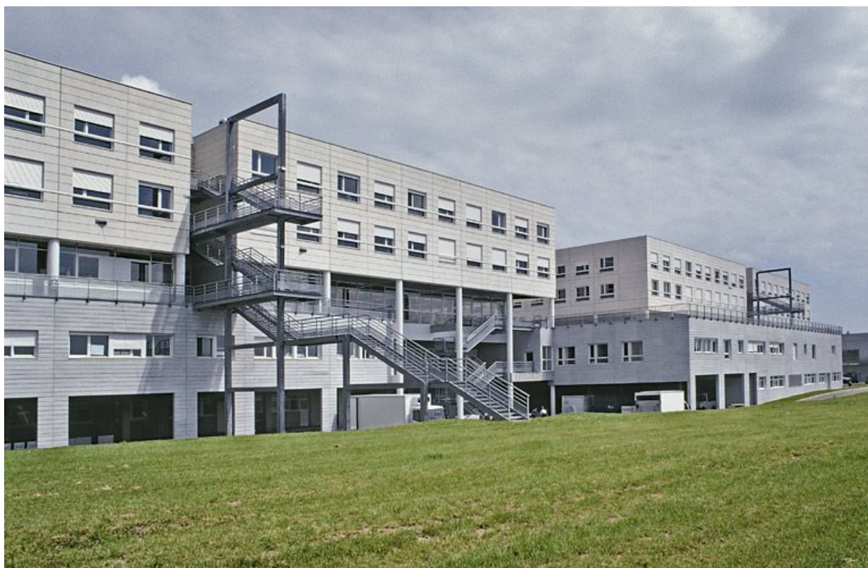
Façade postérieure, partie droite.
