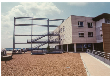
Façades antérieure et latérale. Phot. Jean-Luc Duthu IVR26_20035800201ZA
