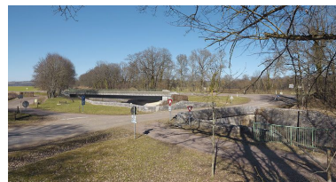
Vue d'ensemble des deux ponts.
