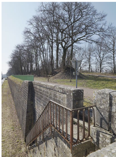
Escaliers d'accès au pont.
