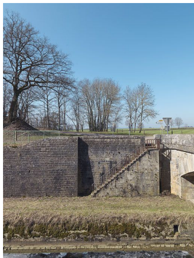
Escaliers d'accès au pont.
