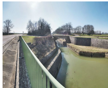
Le pont en pierre de l'aval. On voit les différents niveaux de la tranchée : canal, banquette de halage et sommet.
