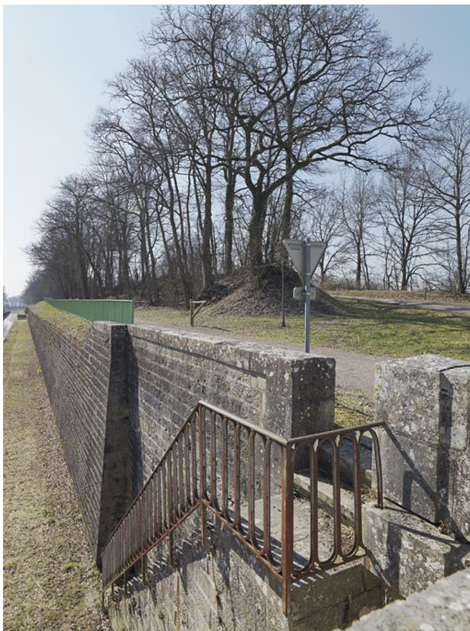
Escaliers d'accès au pont.
