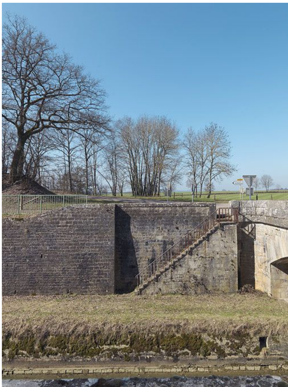
Escaliers d'accès au pont.
