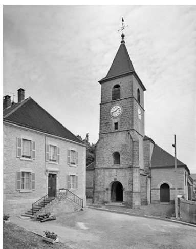
Façade antérieure. Phot. Yves Sancey IVR43_19853900219V
