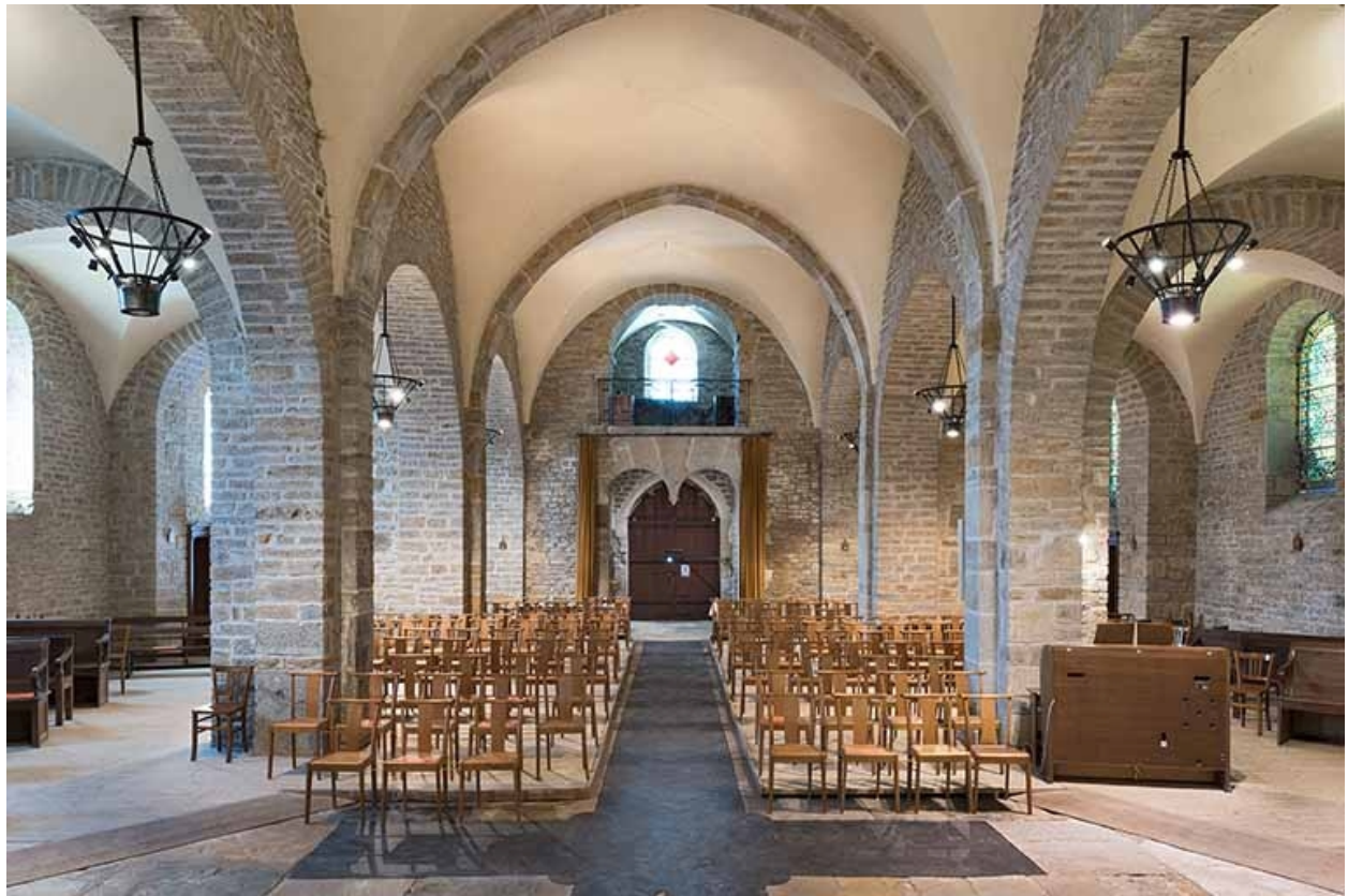
Nef vue depuis le chœur.
