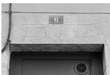
Façade ouest. Détail d'un linteau de porte. Phot. Yves Sancey IVR43_20022500622X
