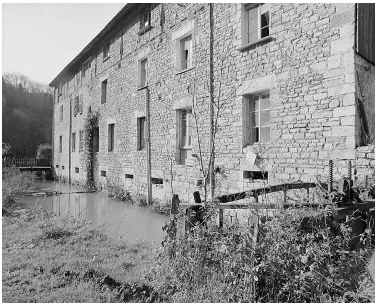
Façade sur le canal.
