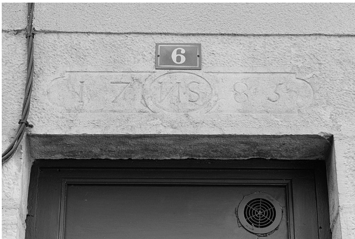
Façade ouest. Détail d'un linteau de porte.
