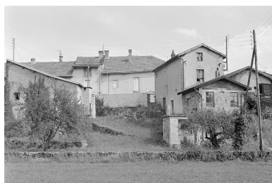
Vue postérieure de l'atelier de pipes. Phot. Jérôme Mongreville IVR43_19963901082X
