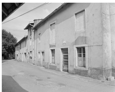
Façade de la ferme sur la rue. Phot. Jérôme Mongreville IVR43_19963901080X
