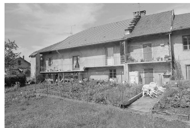
Façade postérieure de la ferme. Phot. Jérôme Mongreville IVR43_19963901087X
