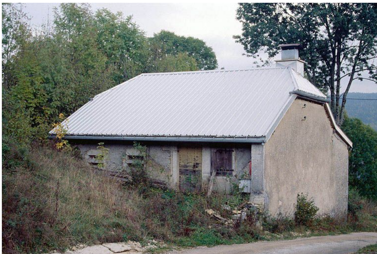
Fromagerie, vue de trois quarts droit.
