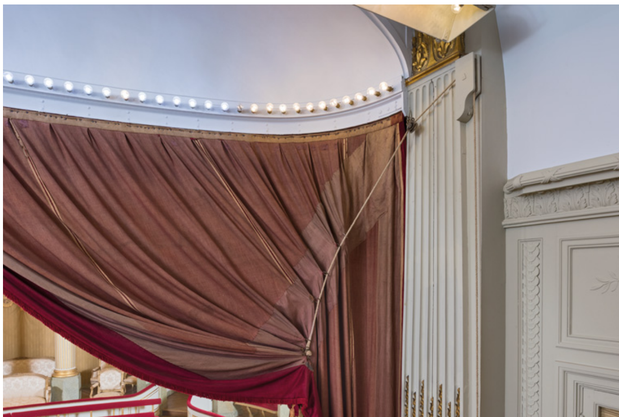
Rideau de scène : détail du système d'ouverture.
