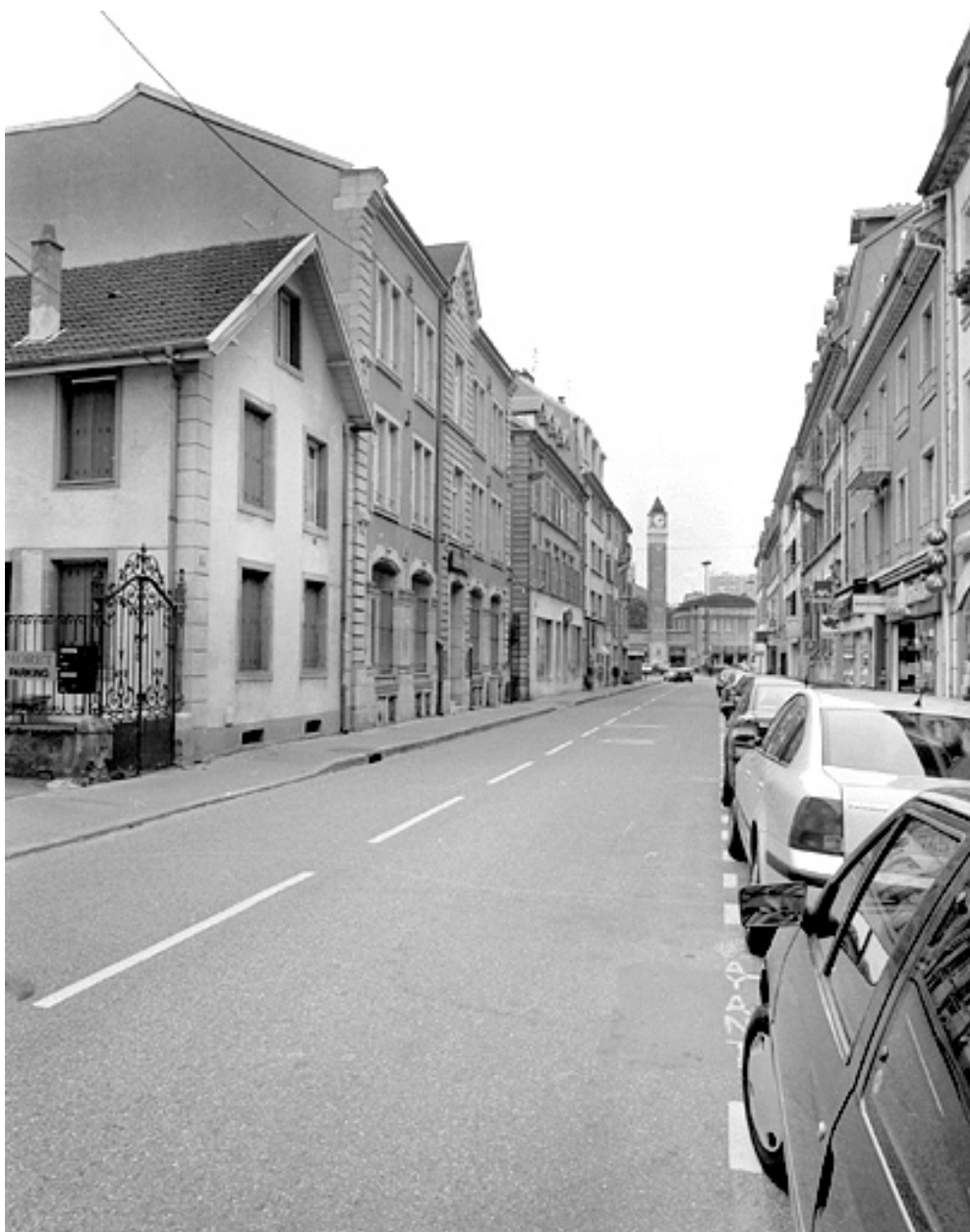
Façades sur rue depuis l'est.
