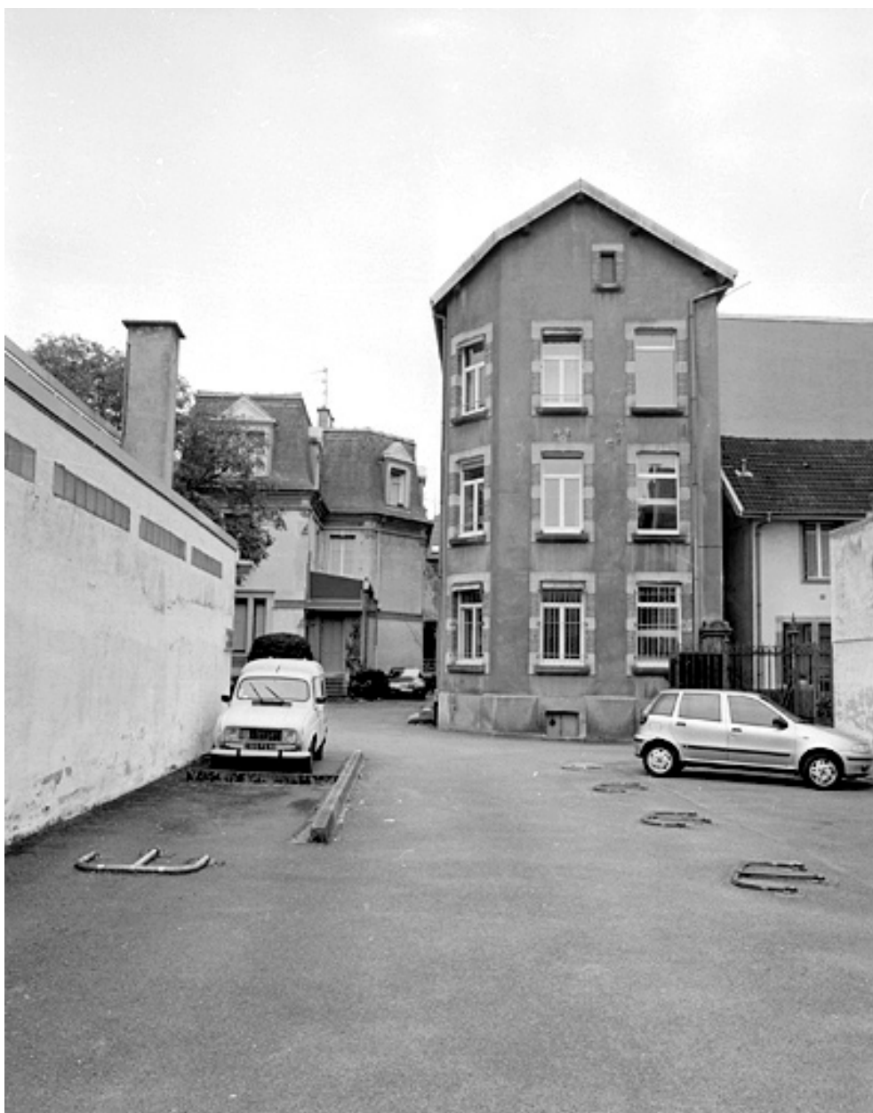
Logement patronal situé à l'arrière du n° 25.
