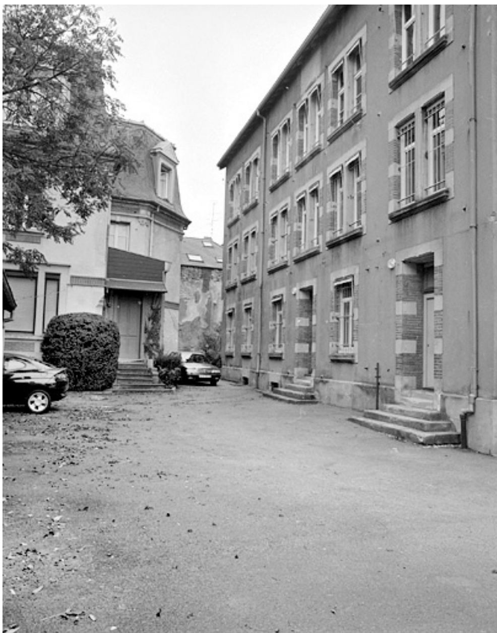
Façade postérieure du bâtiment situé au n° 25.
