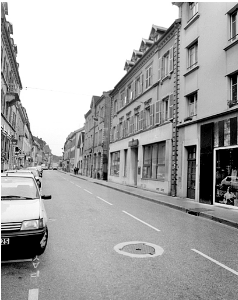
Façades sur rue depuis l'ouest.
