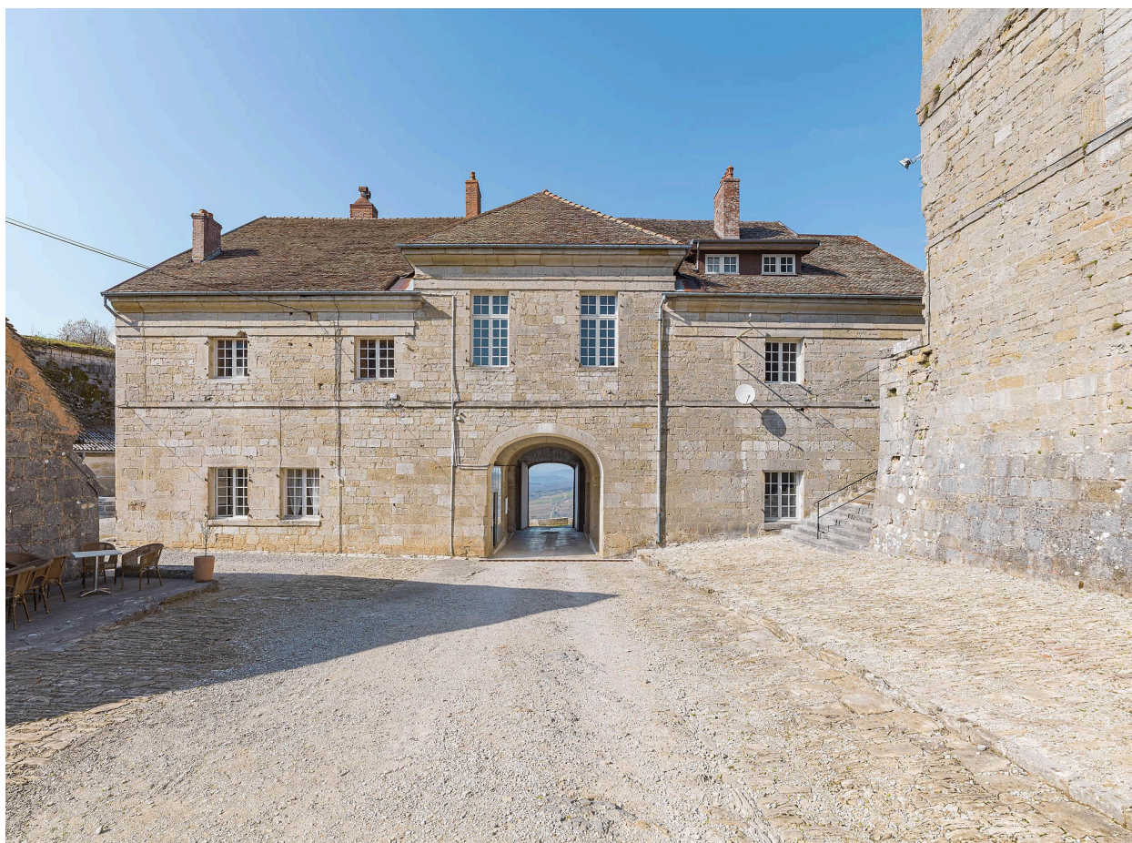
Façade postérieure du bâtiment.
