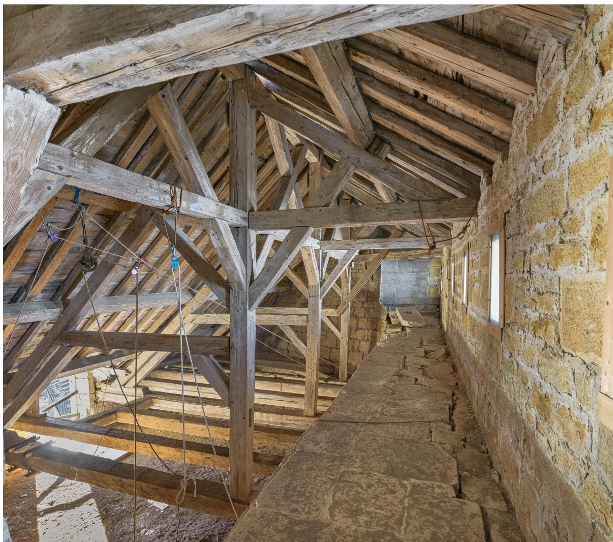
2e étage : charpente du bâtiment.
