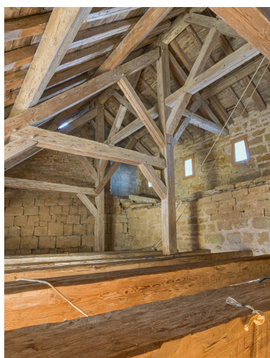
2e étage : détail de la charpente.
