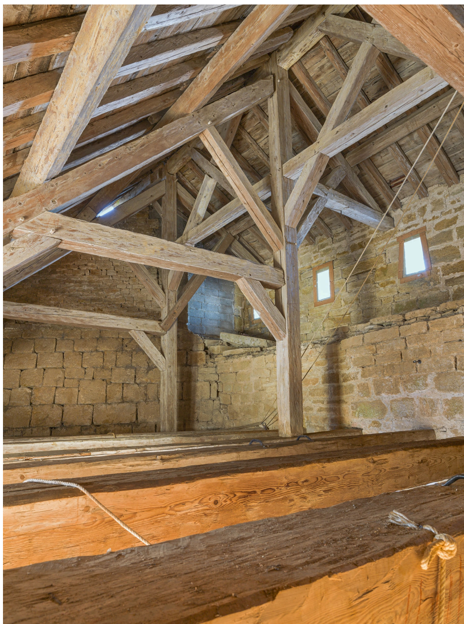
2e étage : détail de la charpente.
