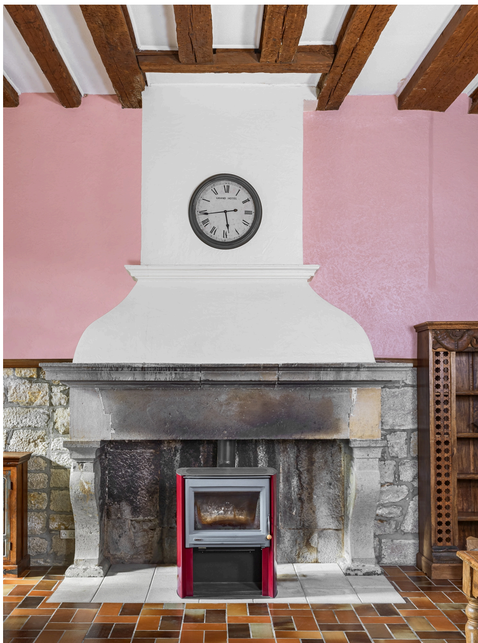
1er étage, logement destiné aux officiers : cheminée.
