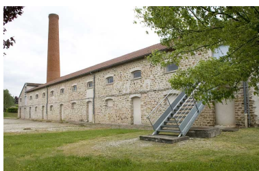
Façade nord vue de trois quarts droite.
