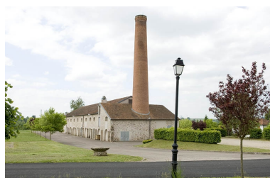
Vue depuis l'est. Phot. Jérôme Mongreville IVR43_20097000556NUC2A
