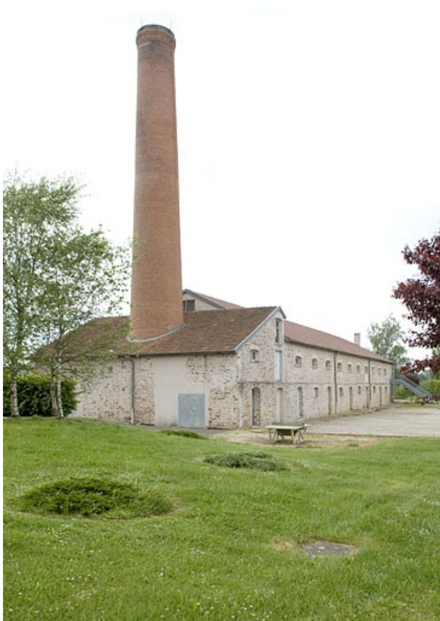
Vue de trois quarts depuis le nord-est.
