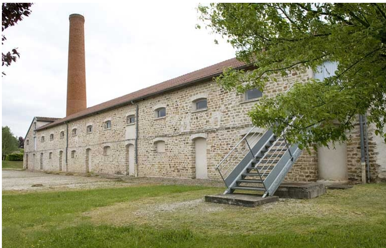
Façade nord vue de trois quarts droite.
