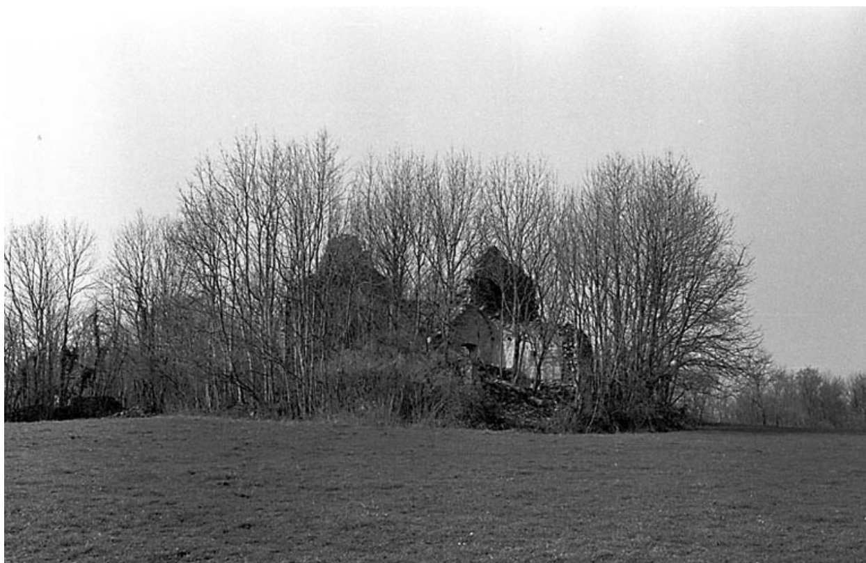
Vue générale des ruines.
