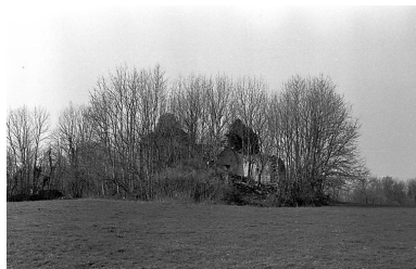
Vue générale des ruines. Phot. Guy Forestier IVR43_19743900315Z
