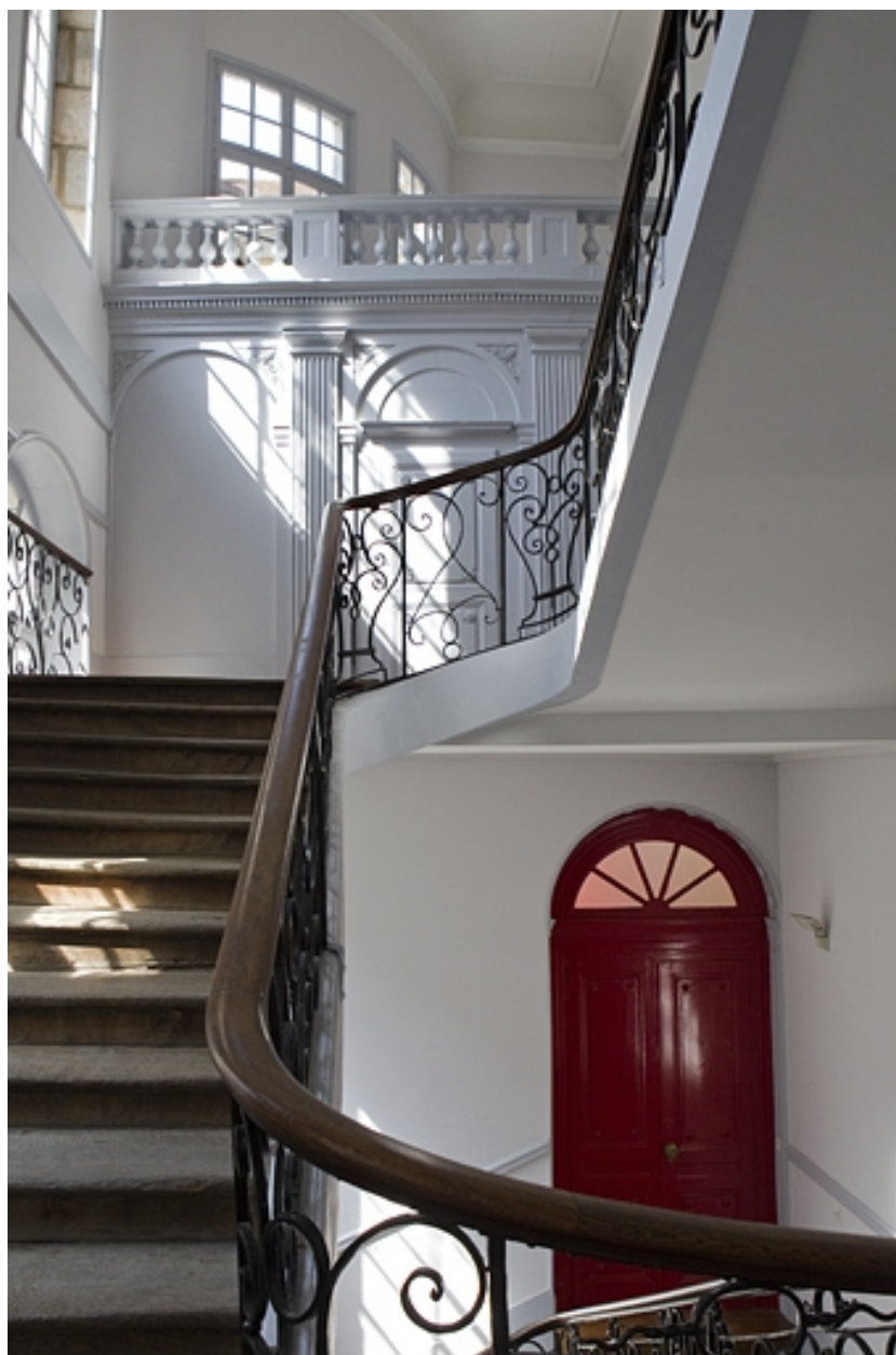
Escalier : détail des volées supérieures.
