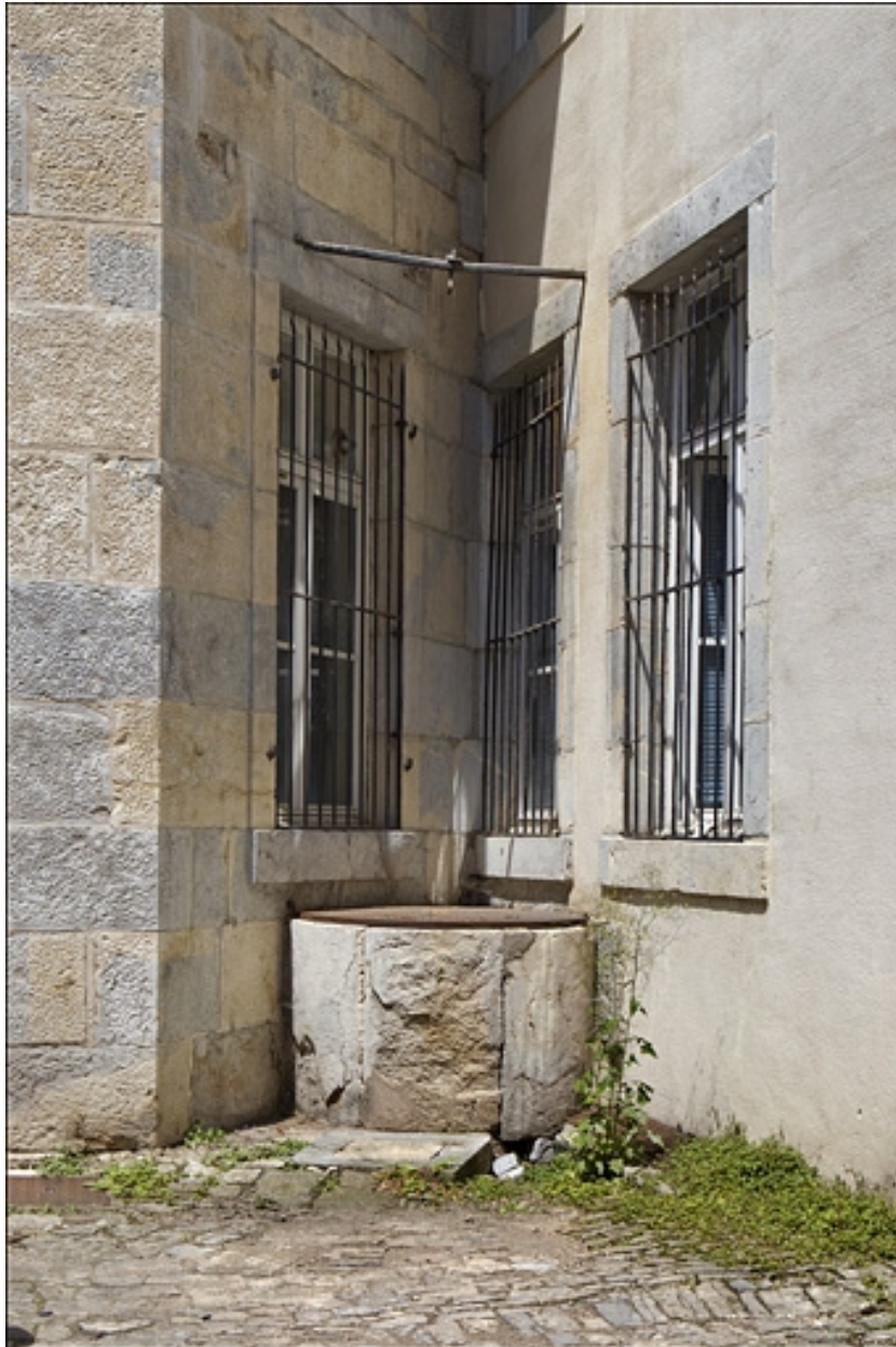
Deuxième cour : détail du puits.
