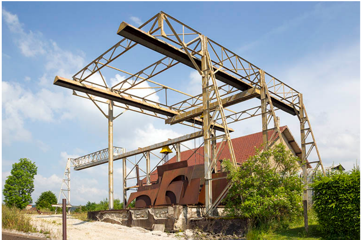
Site rue du Contremont : portique de manutention.
