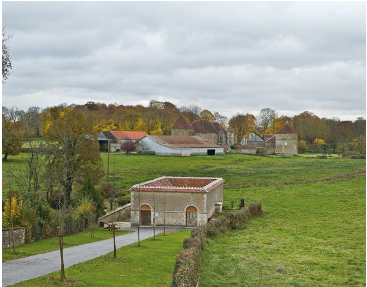
Vue d'ensemble du lavoir.
