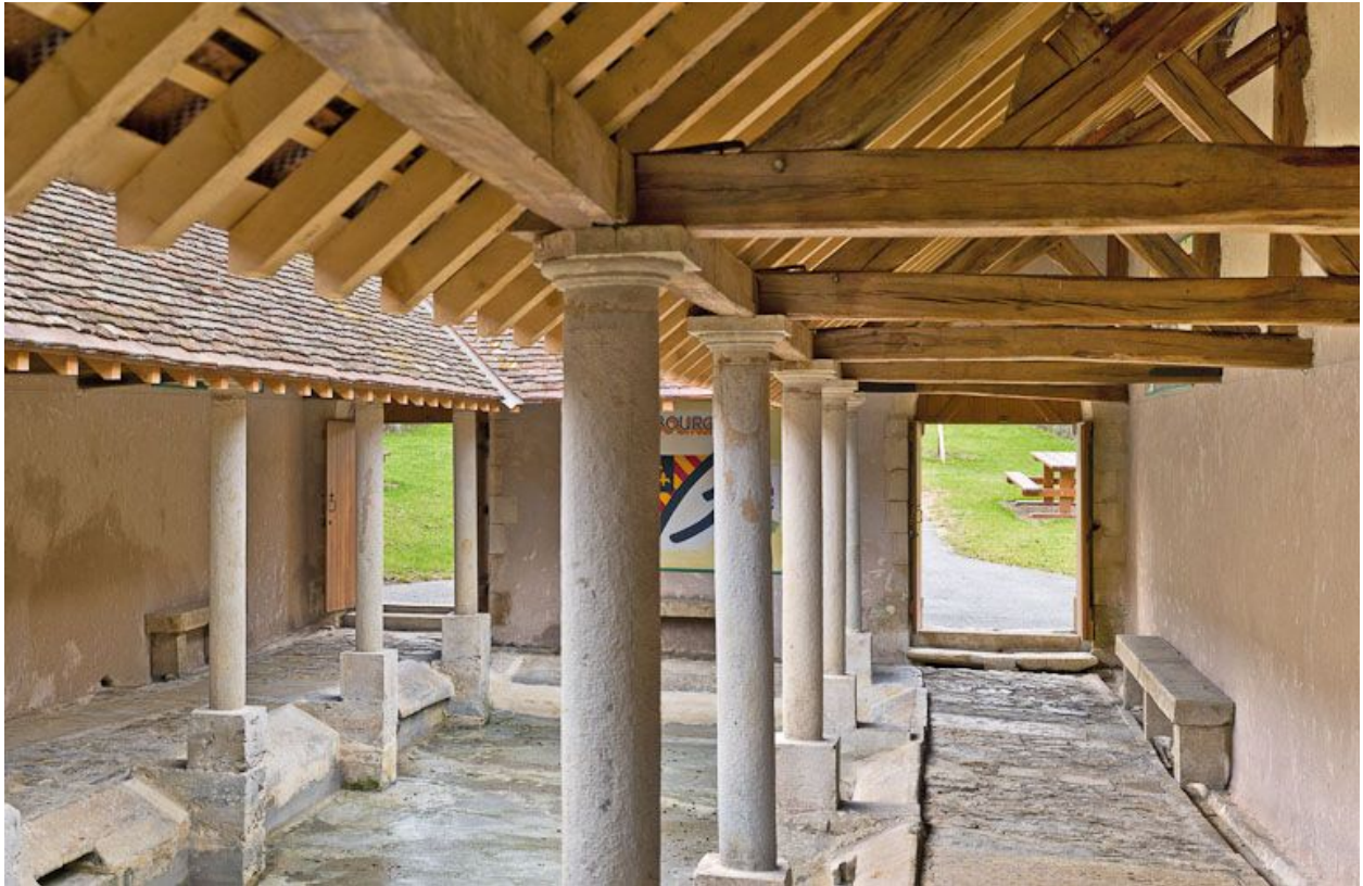
Vue de l'intérieur du lavoir.
