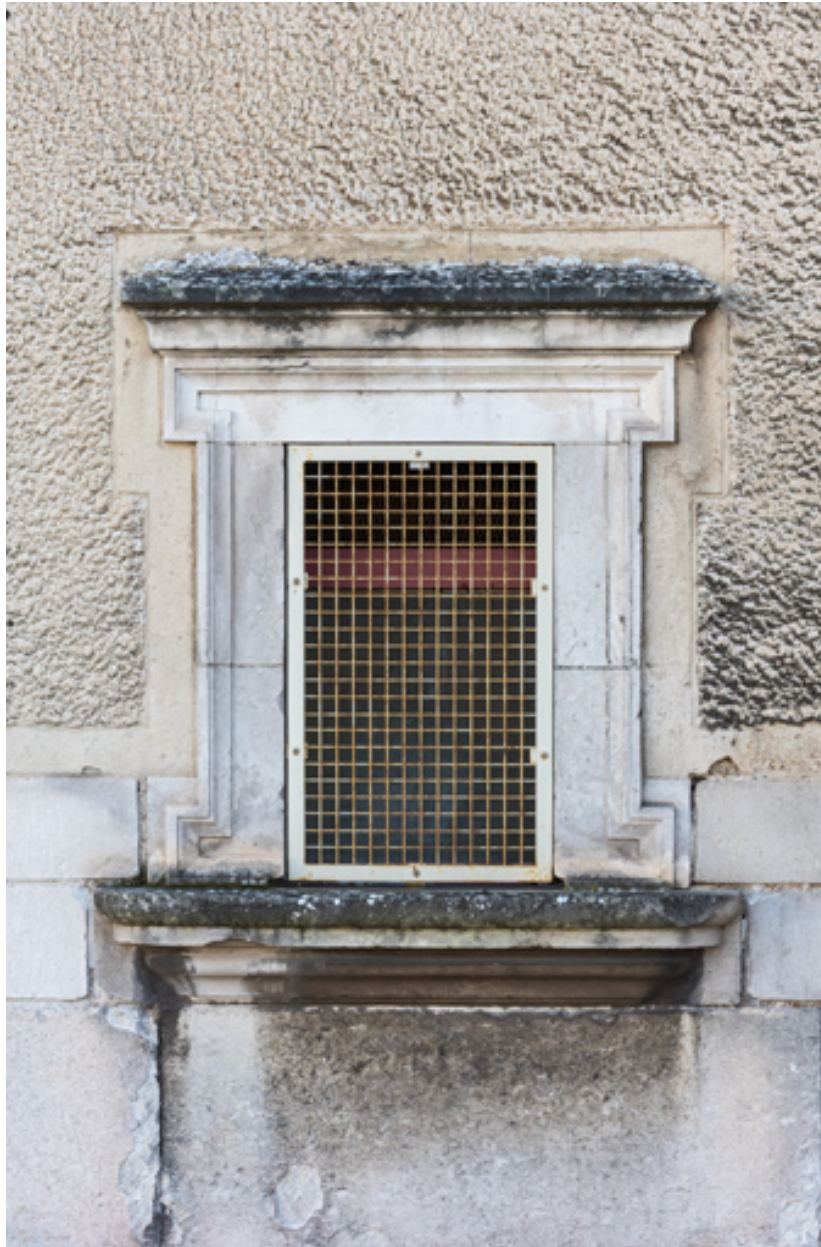
Façade antérieure : ancien guichet, côté jardin.
