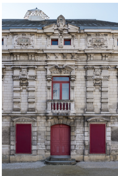
Façade latérale gauche : travées centrales. Phot. Pierre-Marie Barbe-Richaud IVR26_20238900157NUC4A
