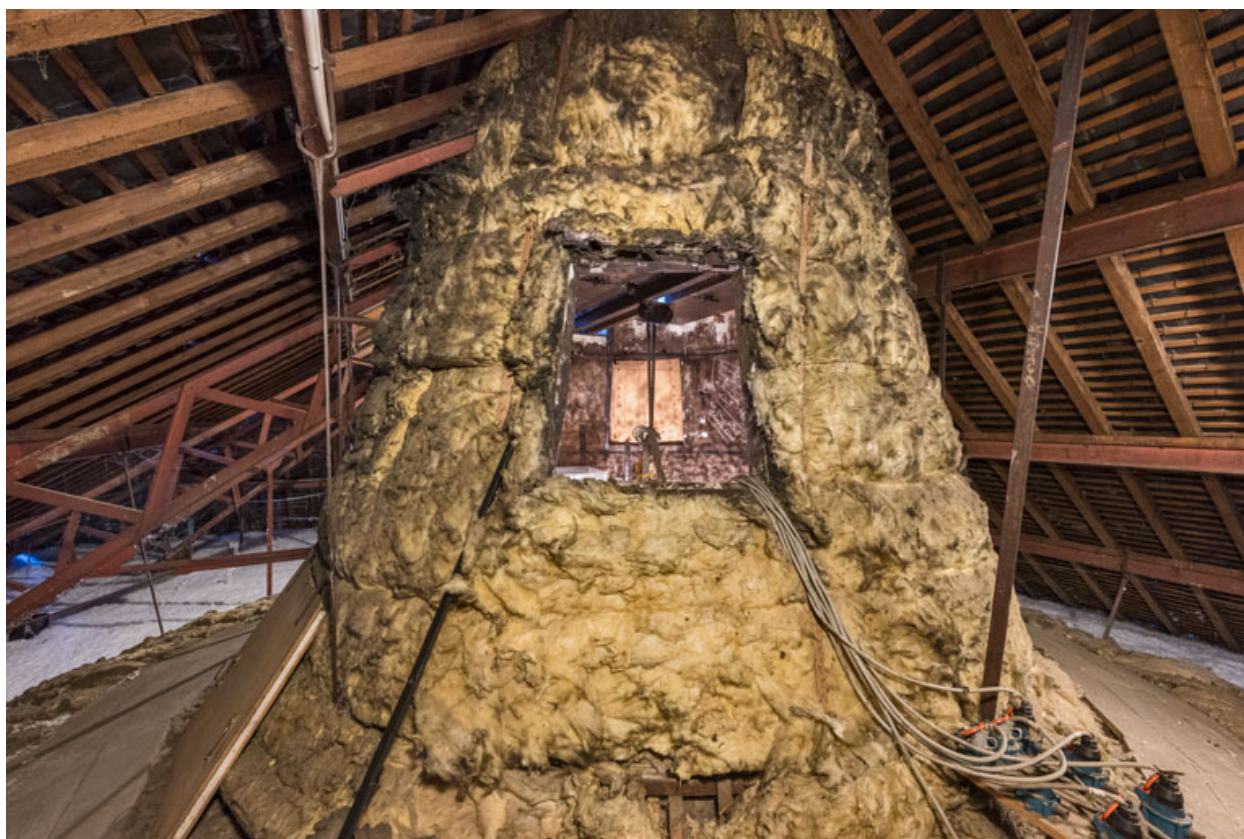
Comble de la salle : cheminée d'aération.
