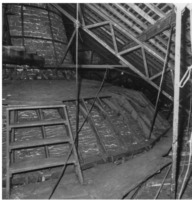
[Armature de la coupole au pied de la cheminée d'aération de la salle]. S.d. [1980 ou 1981].
