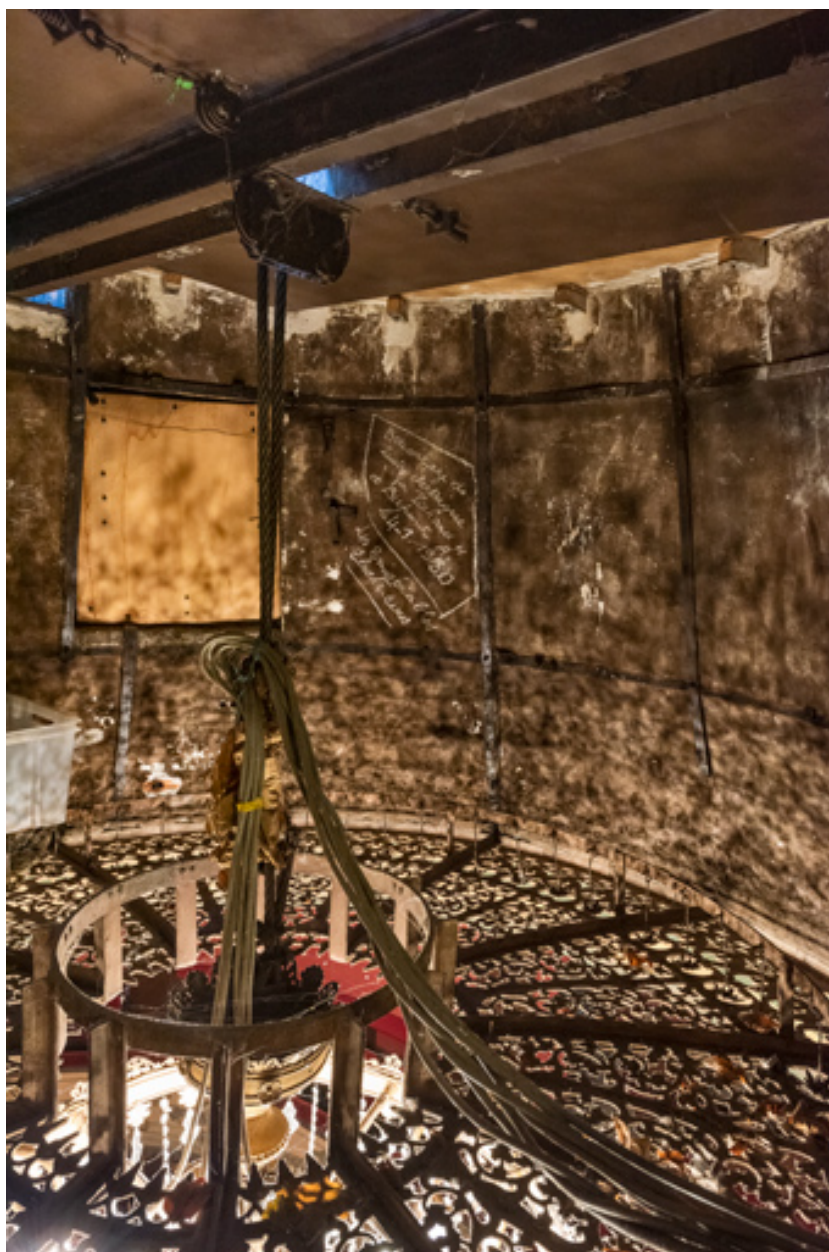
Comble de la salle, cheminée d'aération : intérieur.
