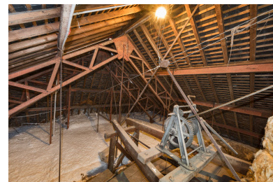
Comble de la salle : charpente métallique et treuil du lustre. Phot. Pierre-Marie Barbe-Richaud IVR26_20238900210NUC4A
