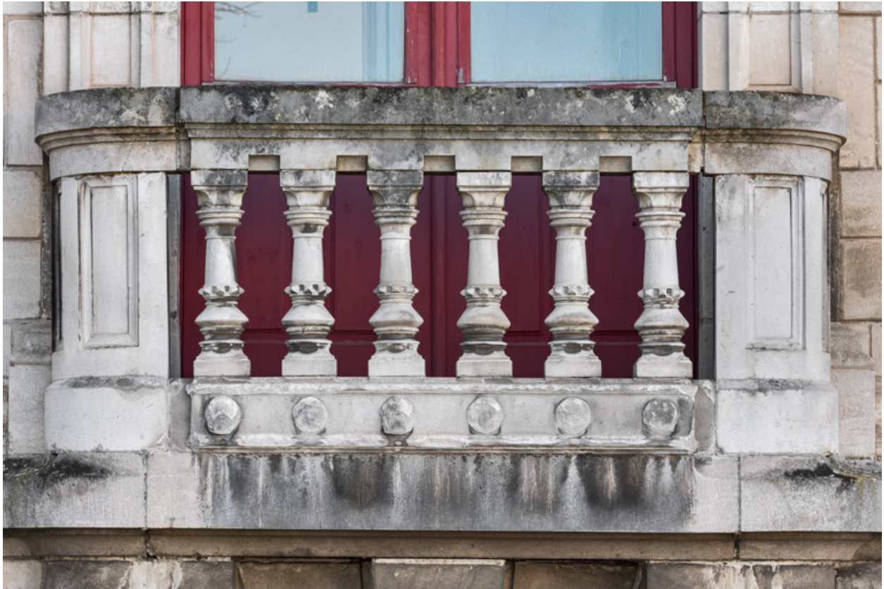
Façade latérale gauche : garde-corps du balcon.
