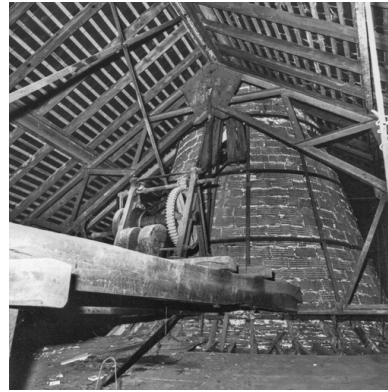
[Cheminée d'aération de la salle, avec le treuil du lustre]. S.d. [1980 ou 1981].
