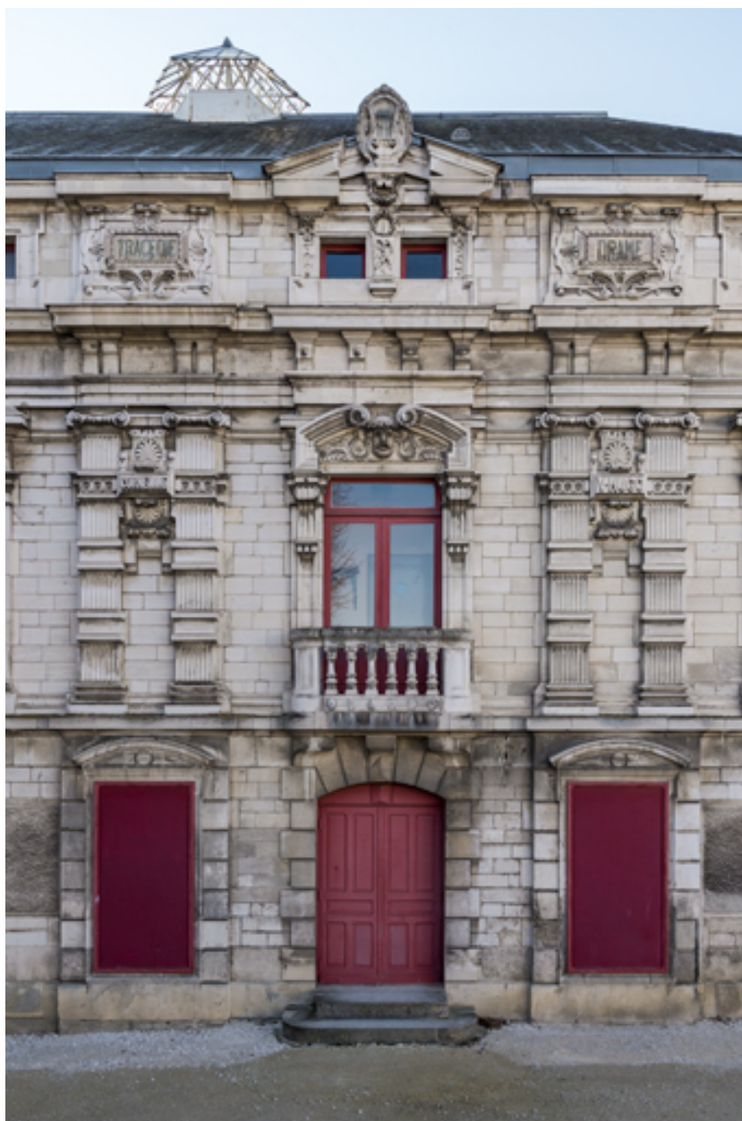
Façade latérale gauche : travées centrales.
