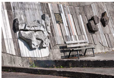
Vue de détail, depuis l'ouest. Phot. Jérôme Mongreville IVR43_20142500414NUC4A
