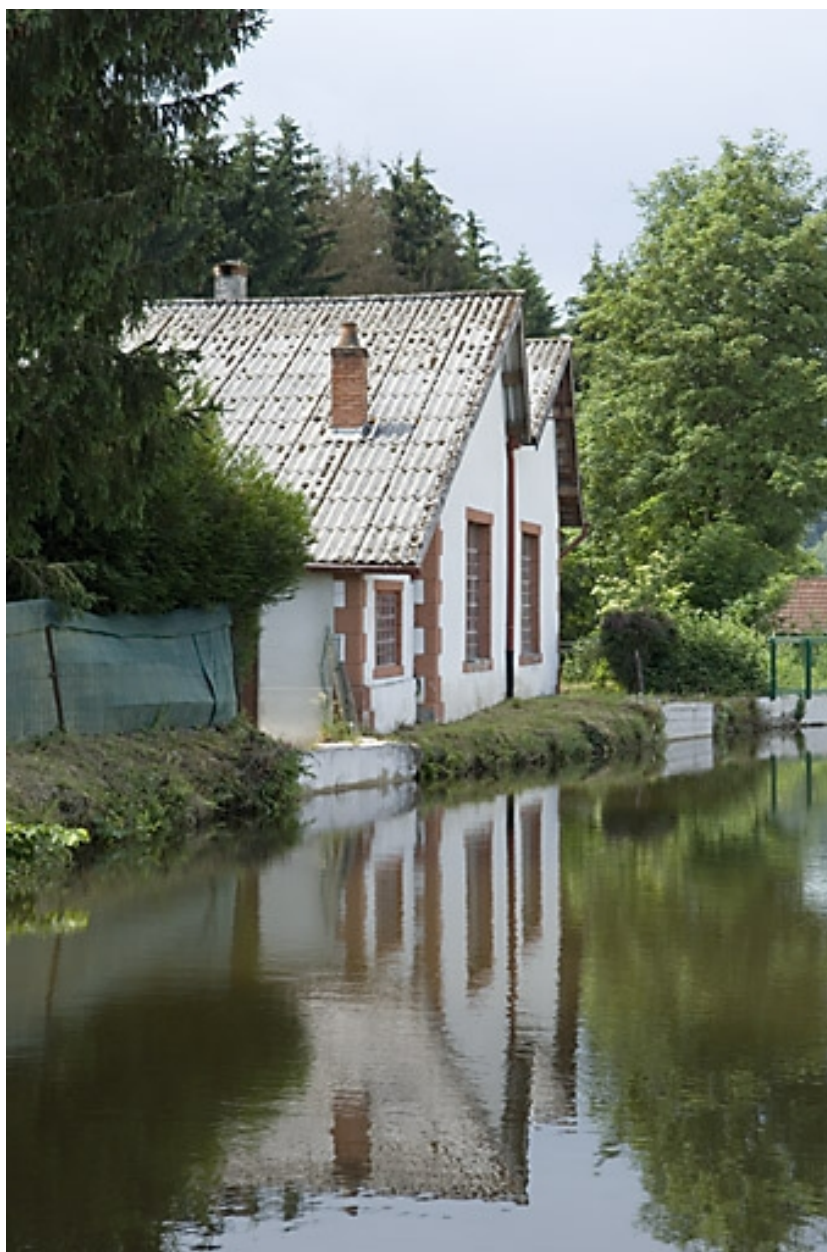
Atelier de réparation sur le bief d'amenée.
