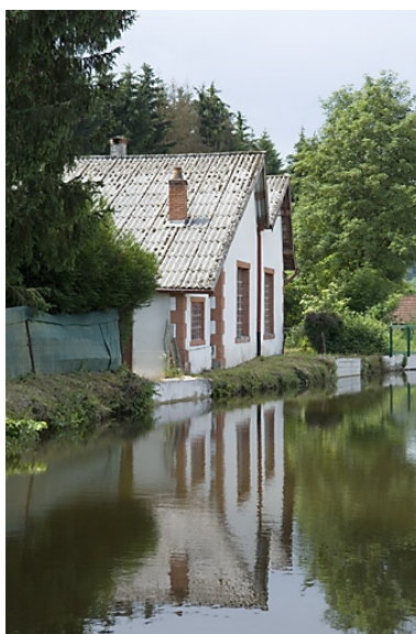
Atelier de réparation sur le bief d'amenée. Phot. Jérôme Mongreville IVR43_20077000168NUCA
