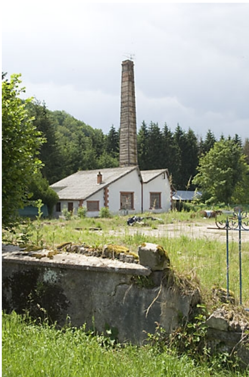
Atelier de réparation et cheminée depuis l'est.
