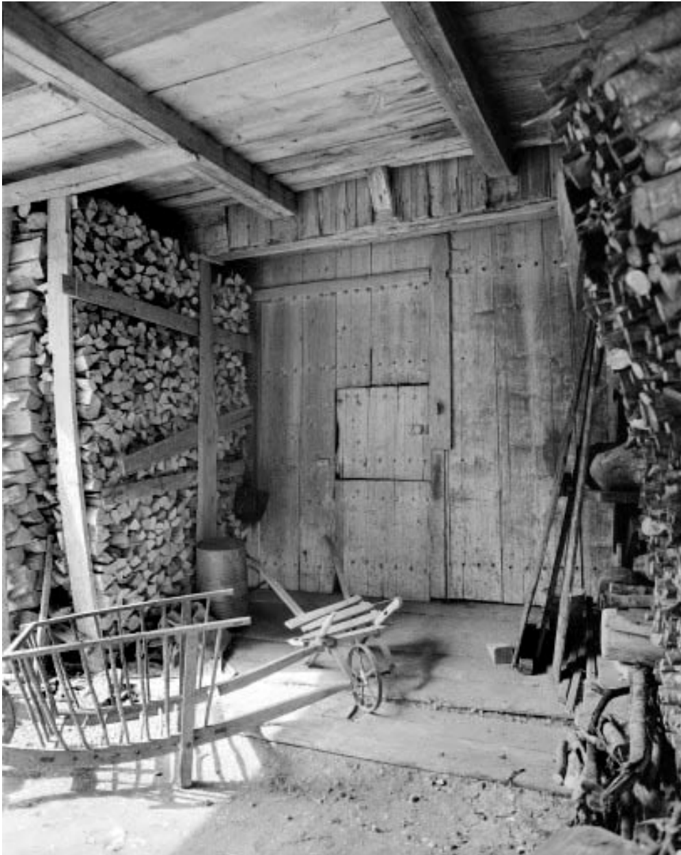
Façade postérieure : porte de grange.
