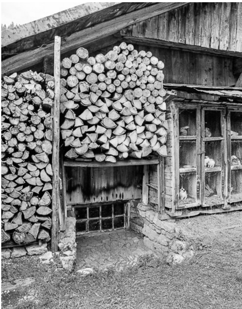
Détail : fenêtre de l'écurie.
