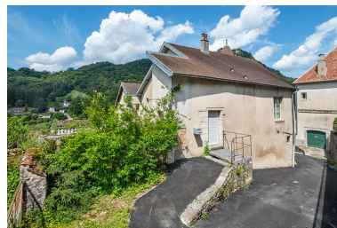
Vue depuis l'entrée de la ruelle. Phot. Jérôme Mongreville IVR43_20243900716NUC4A
