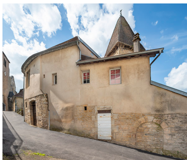
Façade nord, depuis la ruelle d'Arçon. Phot. Jérôme Mongreville IVR43_20243900713NUC4A
