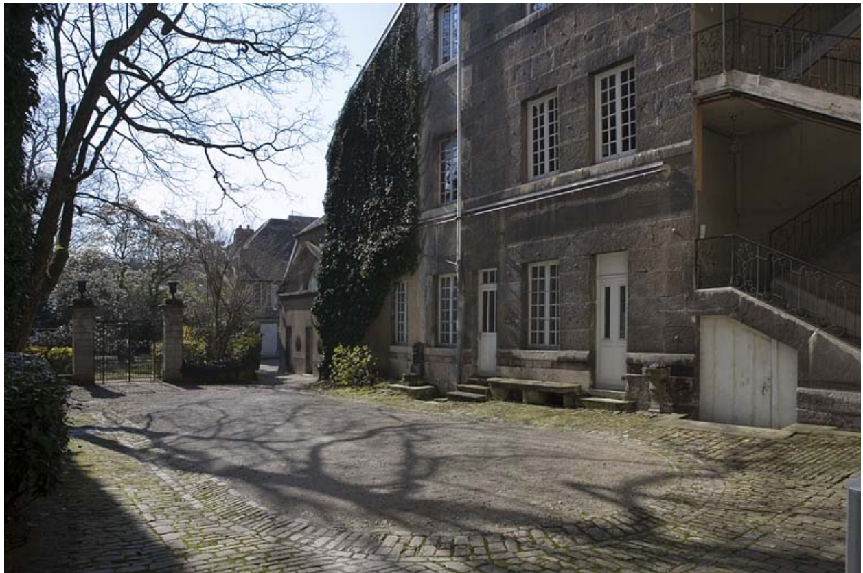
Vue d'ensemble de l'aile sur cour.
