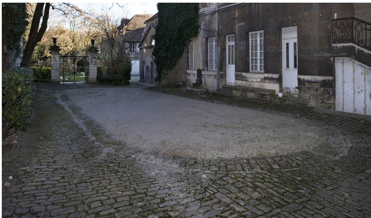
Vue d'ensemble du pavage de la cour.
