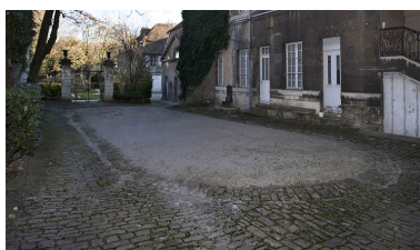
Vue d'ensemble du pavage de la cour. Phot. Yves Sancey IVR43_20072500265NUCA
