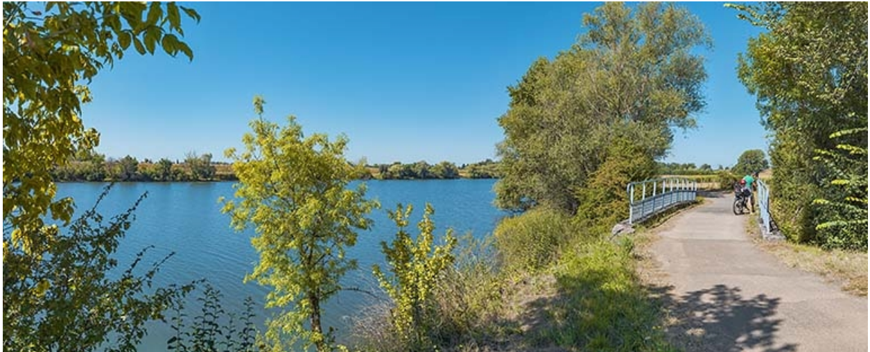
Le pont sur la Vandaine.
