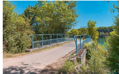
Vue d'ensemble, d'aval. Phot. Thierry Kuntz IVR26_20207100291NUC4A
