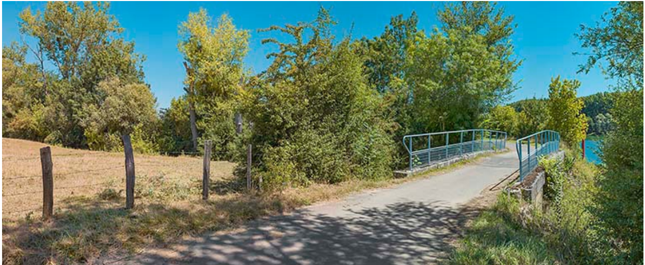
Vue d'ensemble, d'aval.
