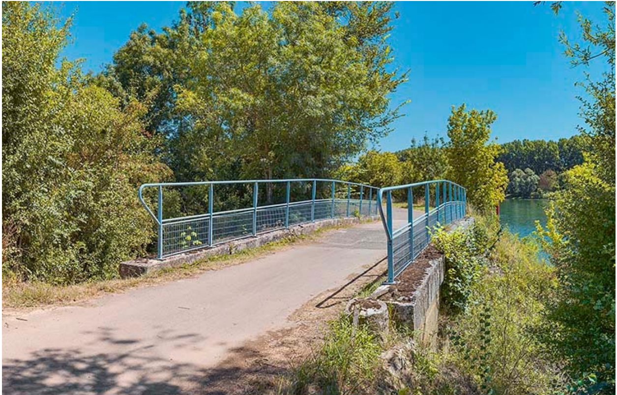
Vue d'ensemble, d'aval.
