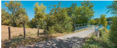
Vue d'ensemble, d'aval. Phot. Thierry Kuntz IVR26_20207100289NUC4A
