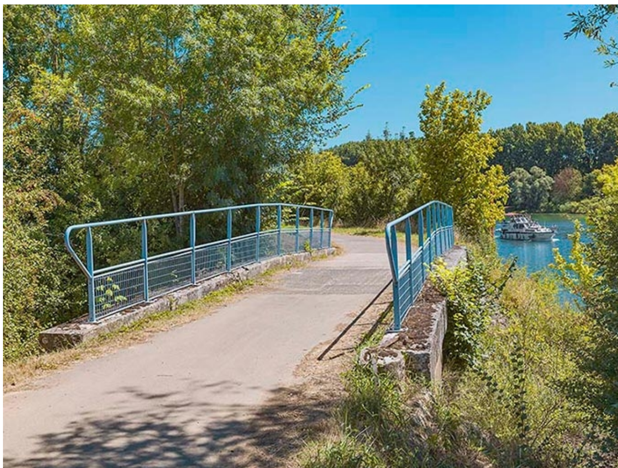
Vue d'ensemble du pont, d'aval.
