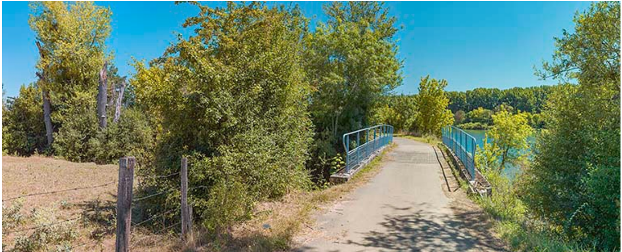
Vue du dessus et d'aval.
