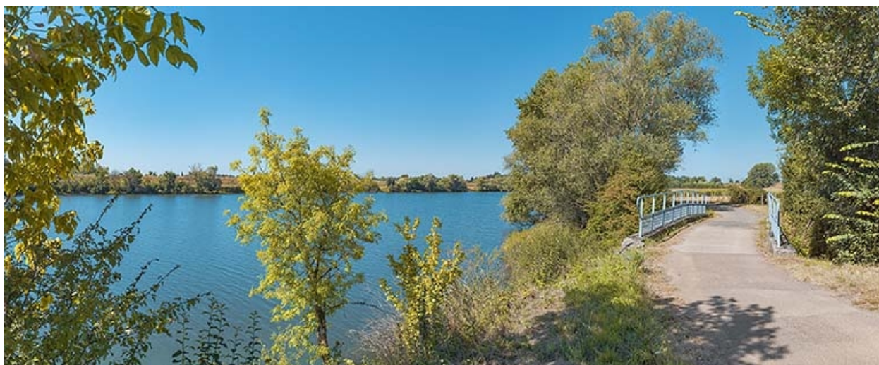
Le pont sur la Vandaine.
