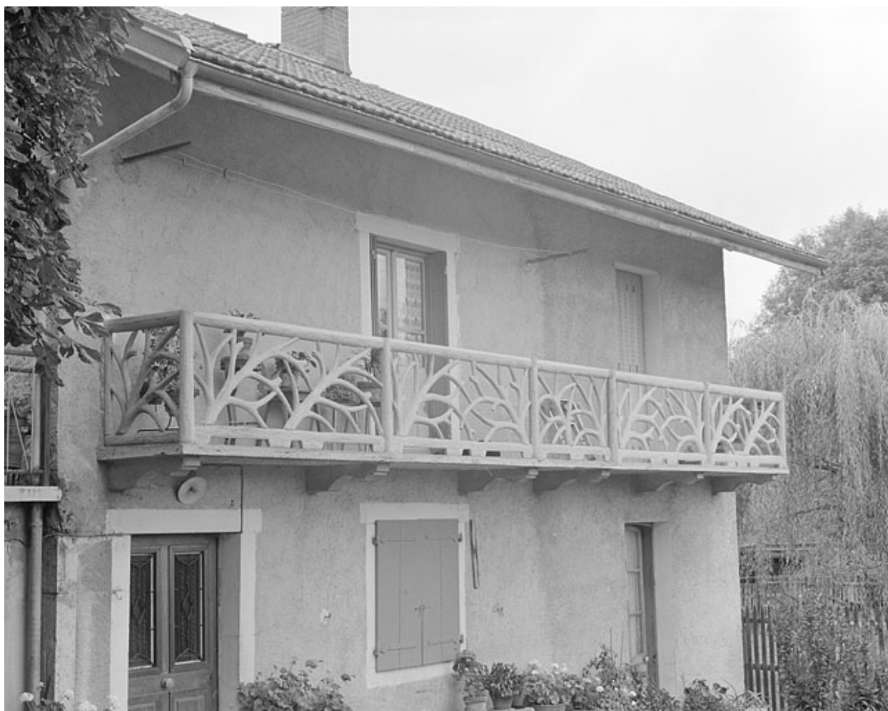
Garde-corps de balcon d'une ferme.
