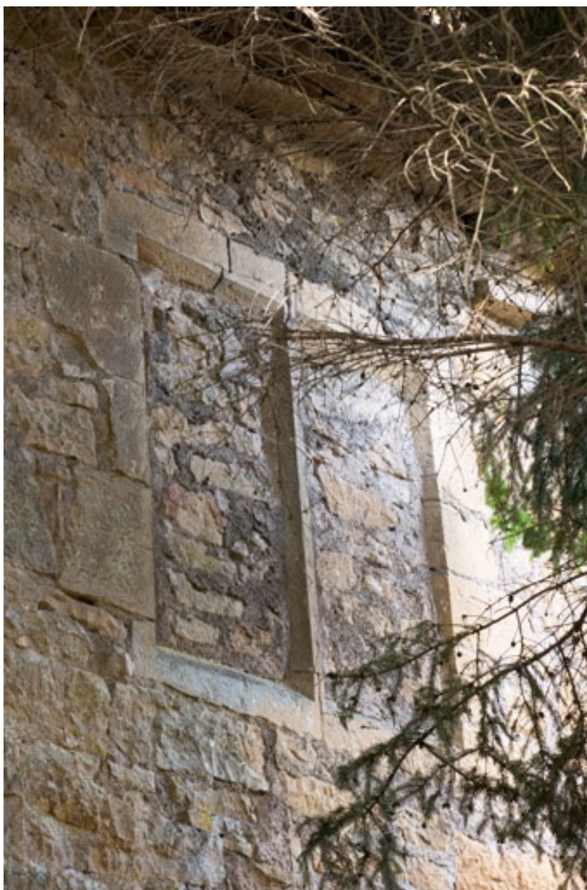
Exemple d'une baie à meneaux (16e siècle) aménagée dans le mur d'enceinte, 7 rue du Vieux Moulin.
