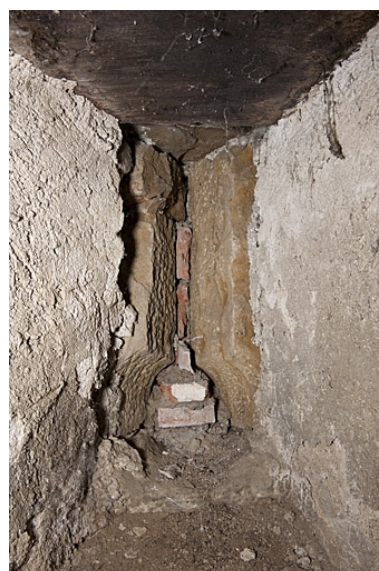
Archère-canonnière en "trou de serrure", 2 rue du Carrefour des Halles. Phot. Jérôme Mongreville IVR43_20112500346NUC4A
