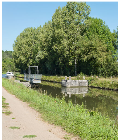
Vue du site. Phot. Pierre-Marie Barbe-Richaud IVR26_20175800394NUC2AQ
