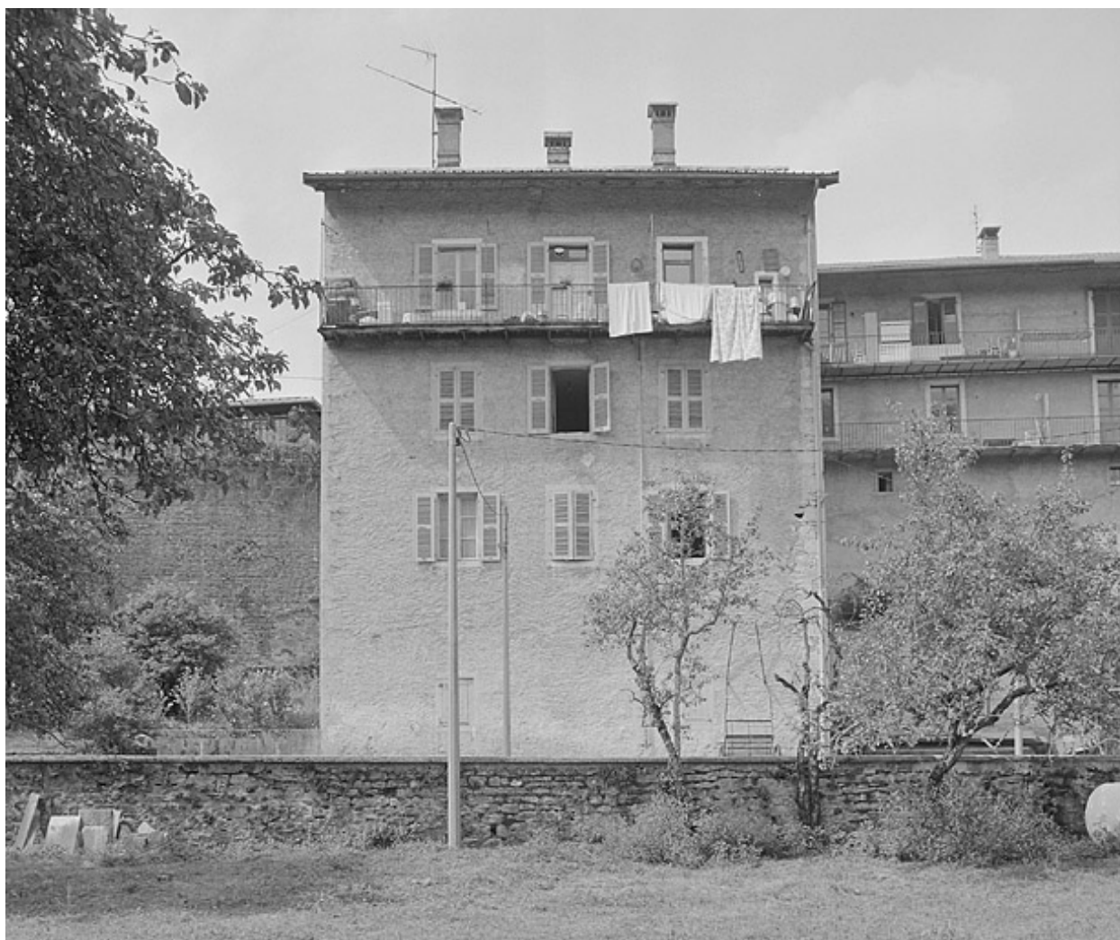
Façade postérieure de l'hôtel.
