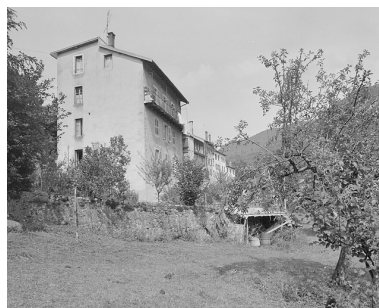
Face droite et façade postérieure. Phot. Jérôme Mongreville IVR43_19963900972X
