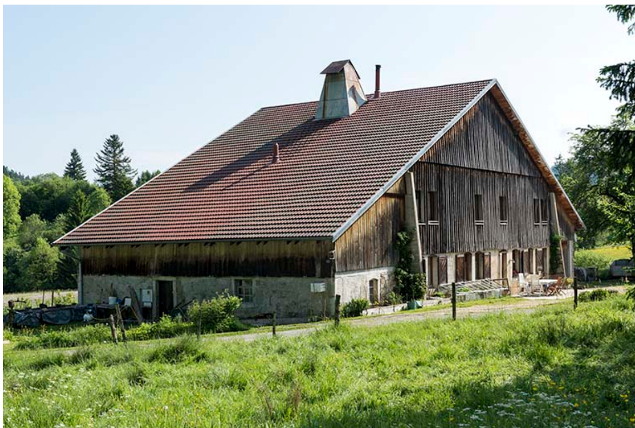
Façades antérieure et latérale gauche.
