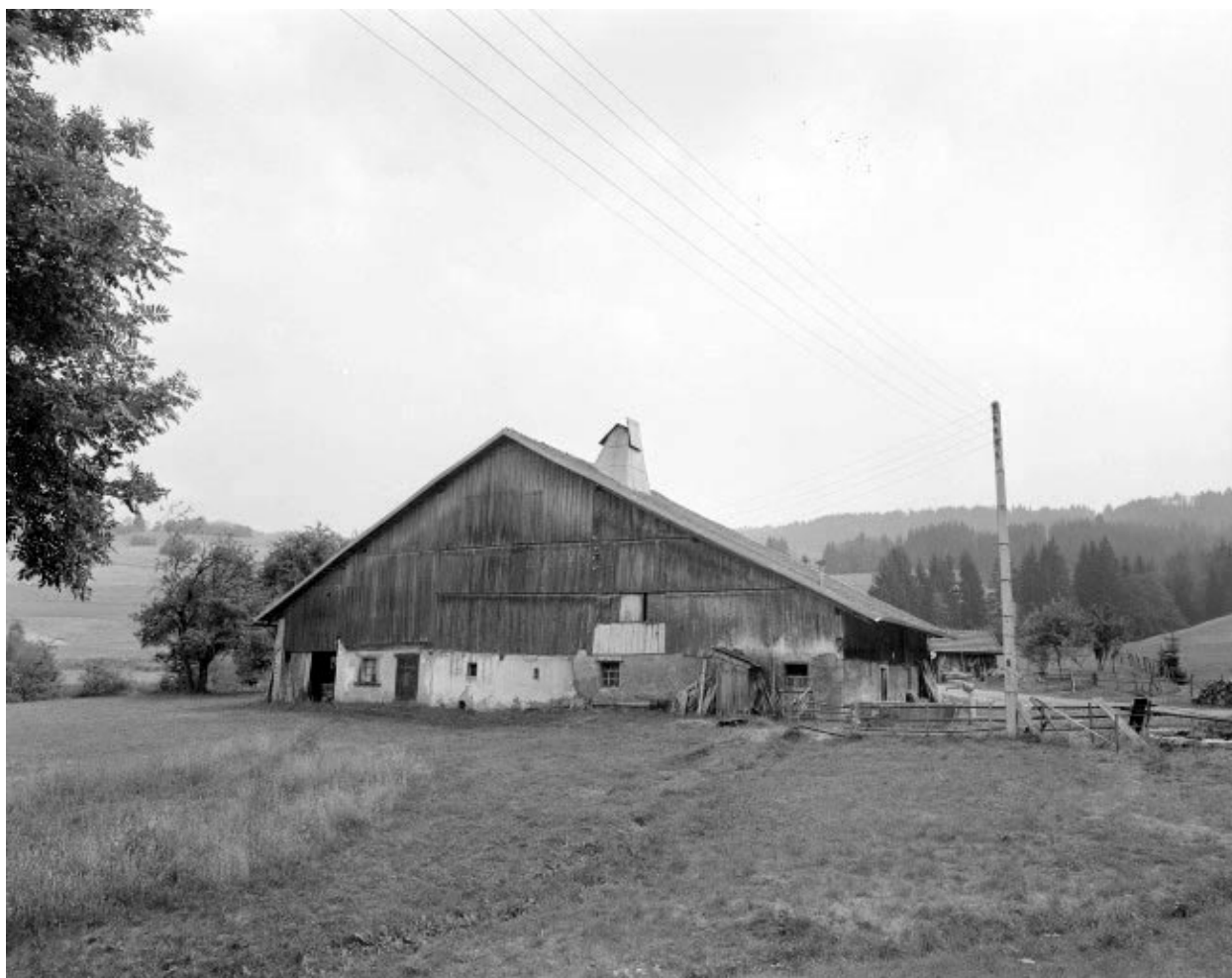
Façade postérieure, en 1976.
