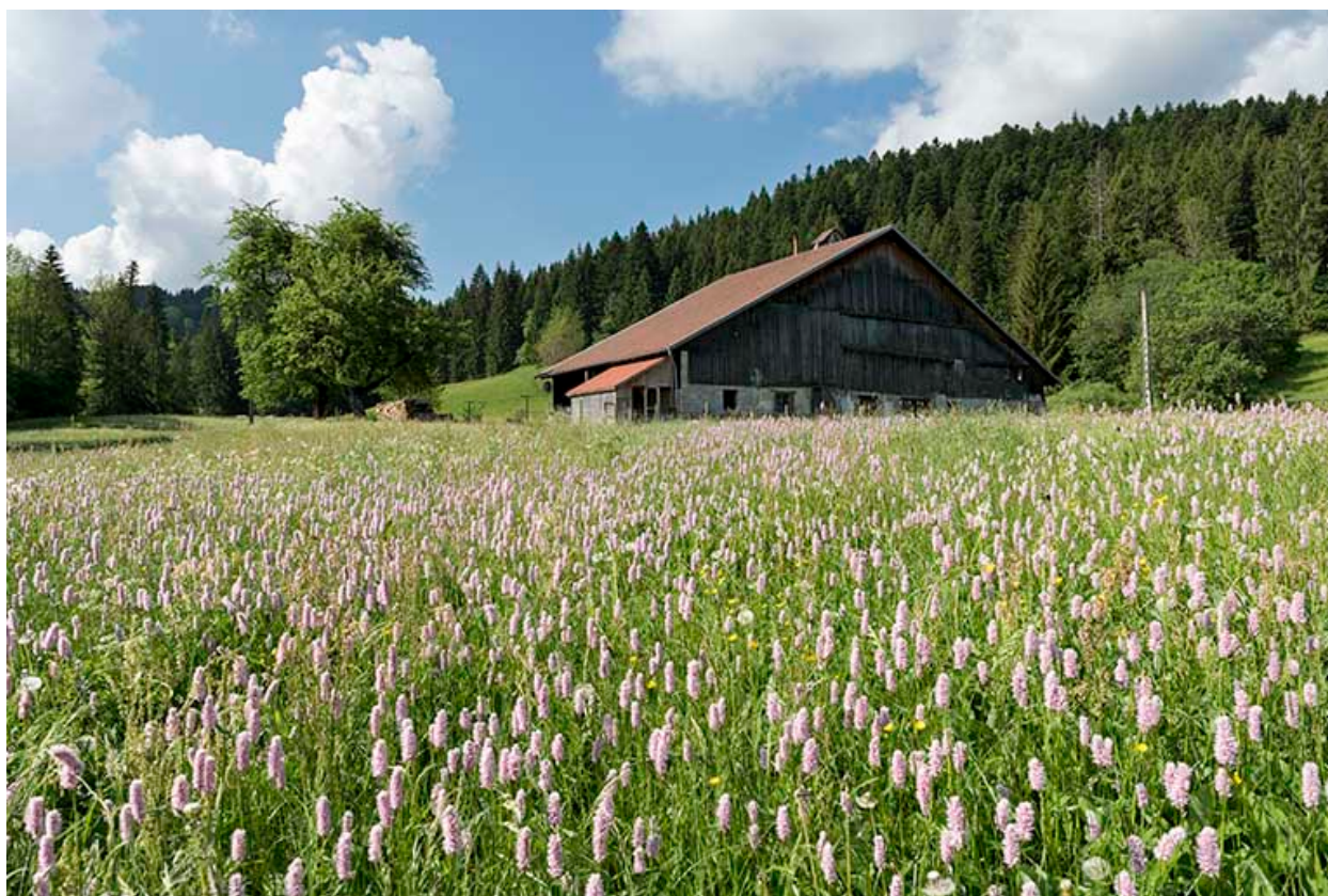
Vue d'ensemble, depuis le nord (façade postérieure).
