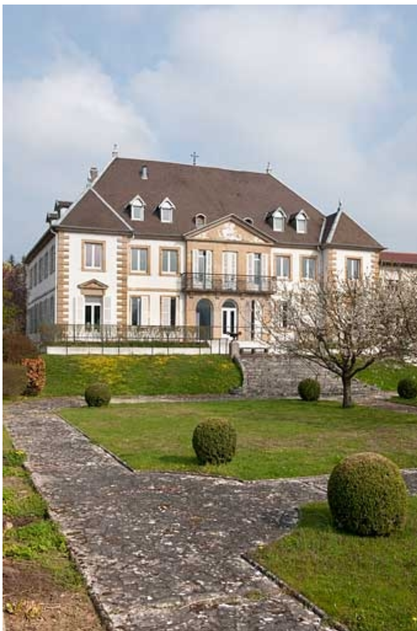
Façade antérieure depuis le jardin.
