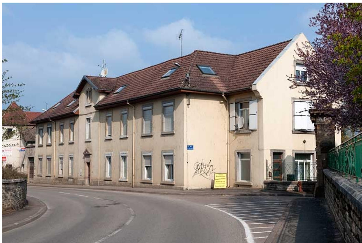
Vue générale de l'ancien pavillon d'isolement.
