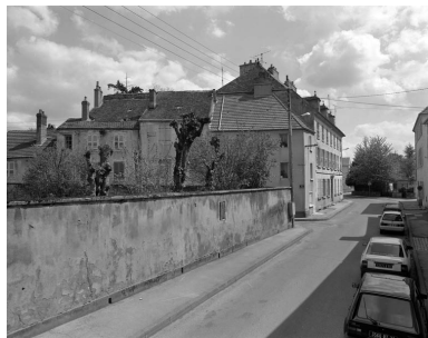
Vue éloignée de trois quarts gauche. Phot. Yves Sancey IVR43_19917000083X
