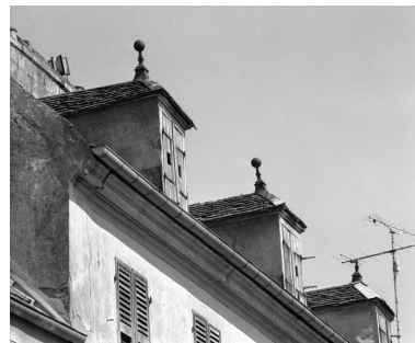
Façade antérieure : détail des lucarnes. Phot. Yves Sancey IVR43_19917000082X
