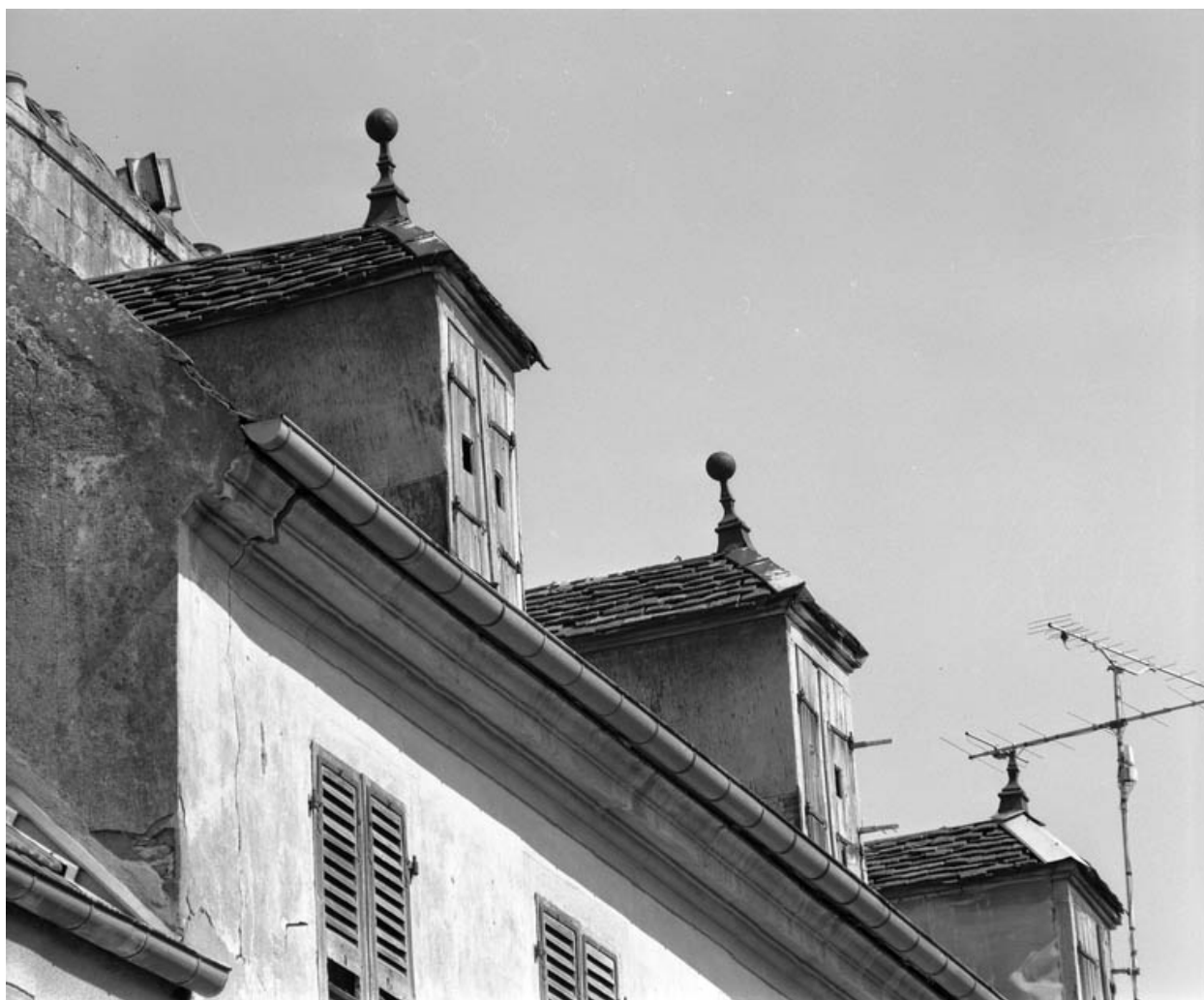
Façade antérieure : détail des lucarnes.
