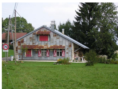
Vue de la façade sud-ouest.
