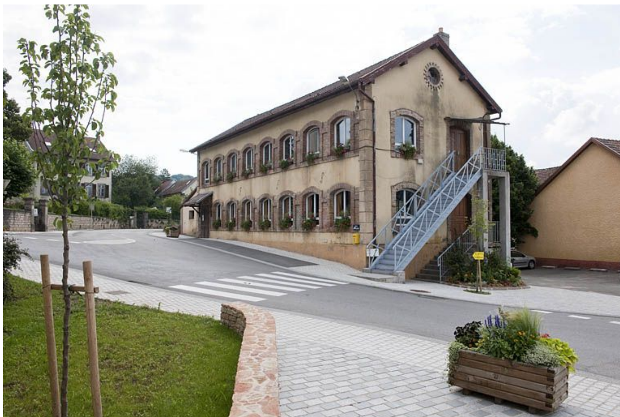
Vue rapprochée depuis l'ouest.
