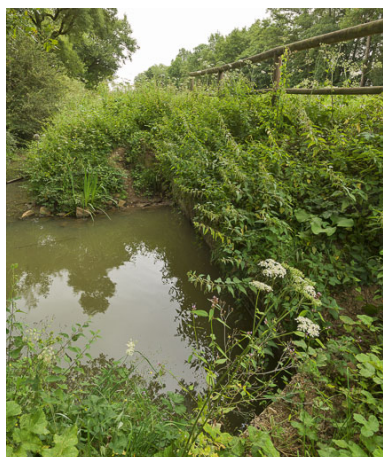
Vue de l'aqueduc.
