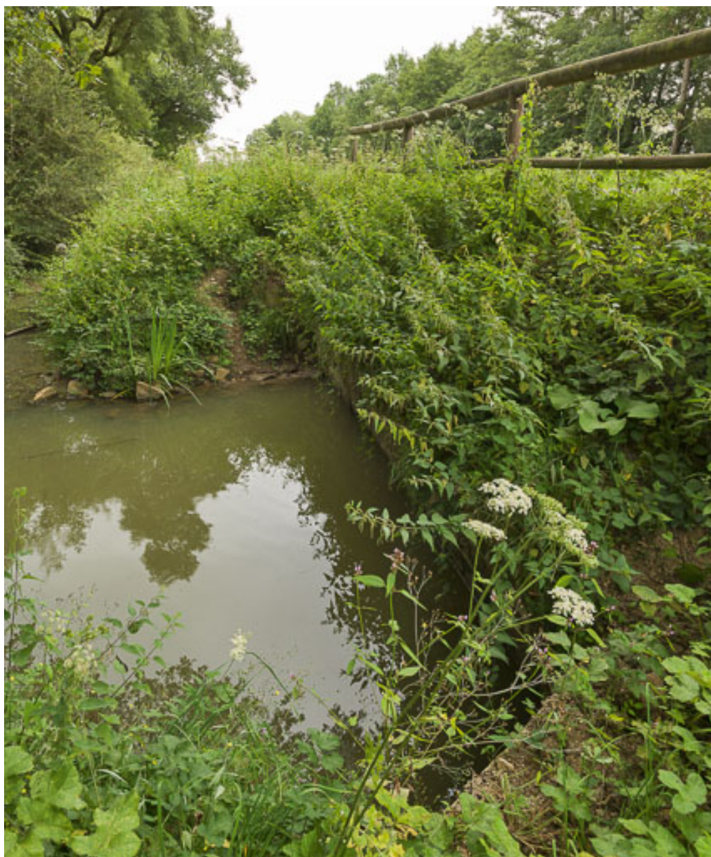
Vue de l'aqueduc.
