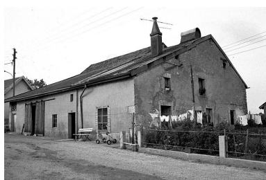
Ferme située rue Sainte- Anne : vue de trois quarts droit. Phot. Gilbert Poinot IVR43_19752500929Z
